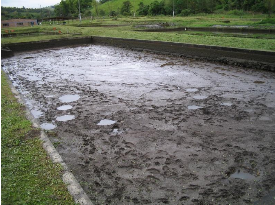
Foto 1. Estanques implementados en la estación piscícola de Pambio.
