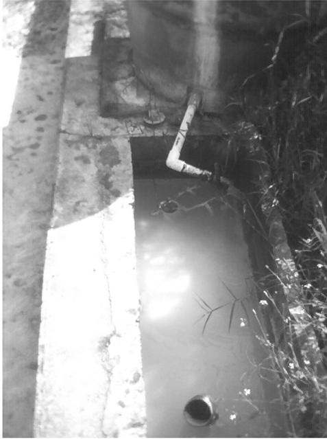
**Fotografía 7. Detalle de la mezcla con el alcalinizante**
