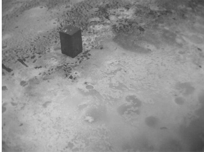
**Fotografía 11. Detalle de la acumulación de mancha y material denso en las cámaras 1-2.**
