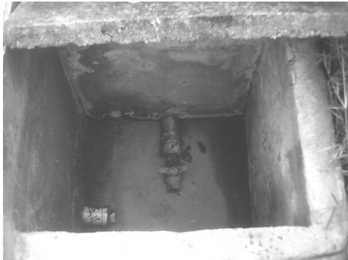
**Fotografía 8. Detalle de las cámaras laterales para salida de lodo**
