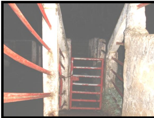
Fotografía 1. Estructura de recepción de ganado
