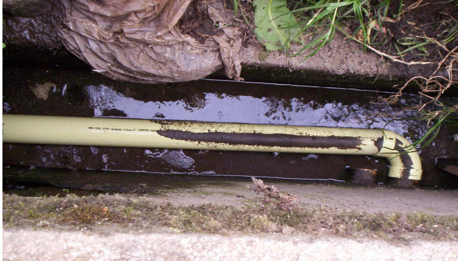
Figura 1. Adaptación de tubería de salida de lodos
