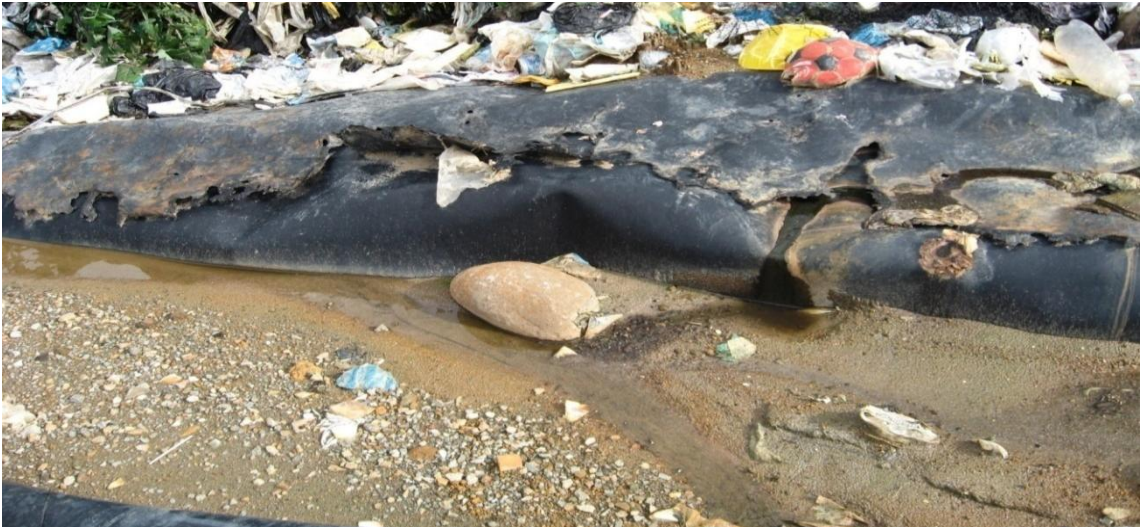
Figura 5. Canal perimetral que recoge el lixiviado del relleno sanitario “El Ojito “
