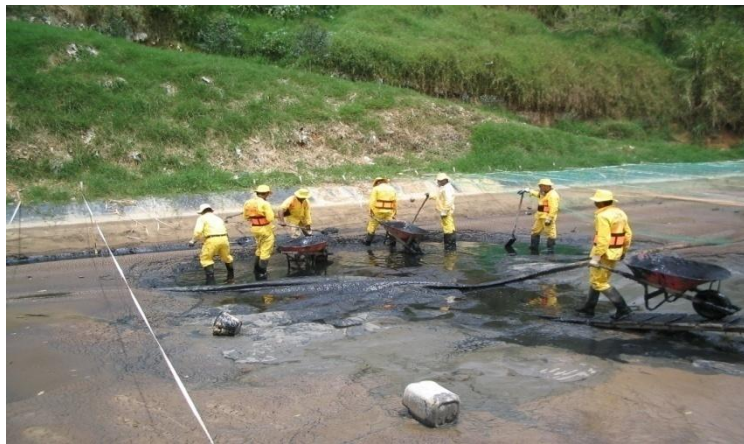
Figura 6. Limpieza realizada a la laguna de lixiviados del relleno sanitario “El Ojito” en 2006.
