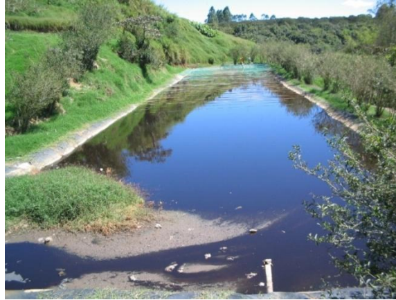
Figura 8. Laguna de estabilización de lixiviados del relleno sanitario “El Ojito” 2006.
