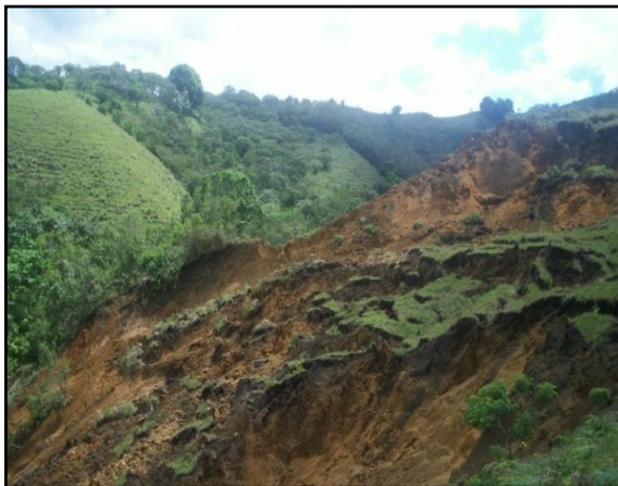
FIGURA 19. DERRUMBE EN LA MICROCUENCA DE LA QUEBRADA CHIGUARÁ
