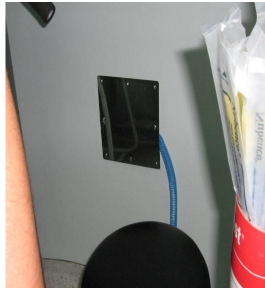
Figura 18. Manguera sin equipo de extracción
