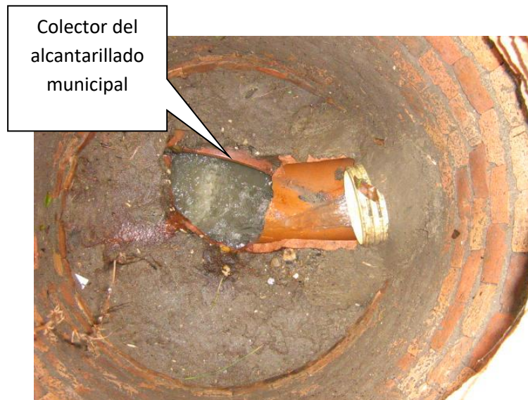
Figura 15. Relación de llenado de 0.8 aproximadamente en el colector del alcantarillado (verano)
