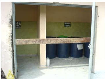
Fotografía 39 Sitio de Almacenamiento sin las especificaciones características reglamentadas
