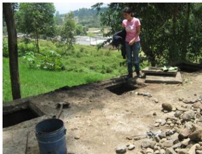
Fotografías 78 y 79 Tanques sépticos que estaban en etapa de reparación y mantenimiento
