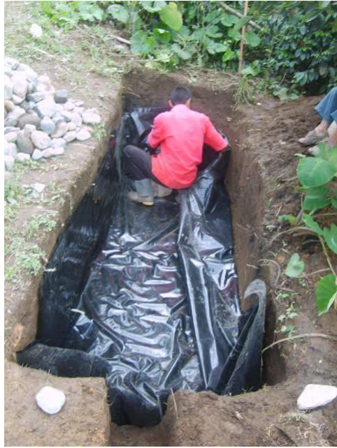
Figura 38 a. Impermeabilización del filtro Figura 38 b. Disposición del lecho de piedra
