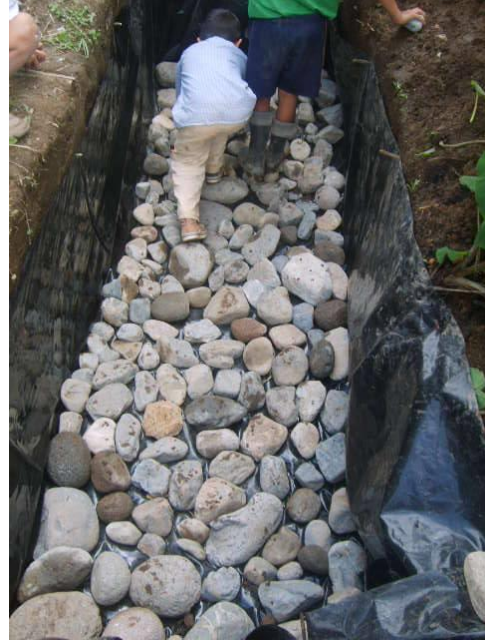
Figura 38 a. Impermeabilización del filtro Figura 38 b. Disposición del lecho de piedra
