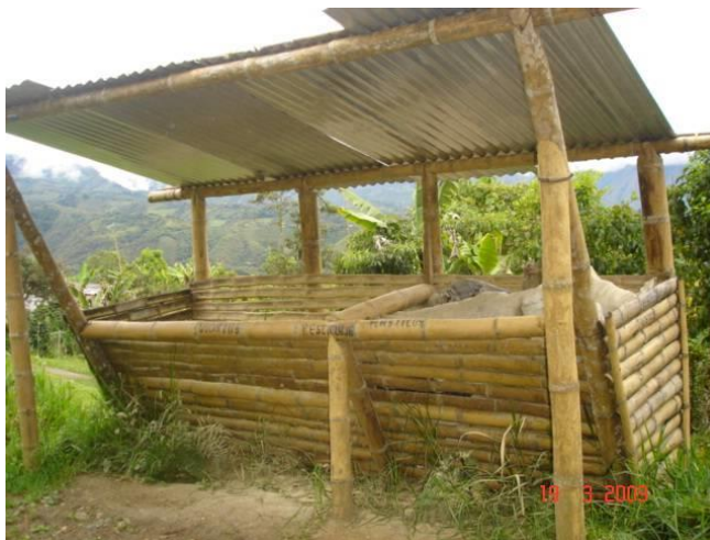
Figura 25. Caseta para separación de residuos sólidos inorgánicos, vereda de Providencia, ASPROSI.
