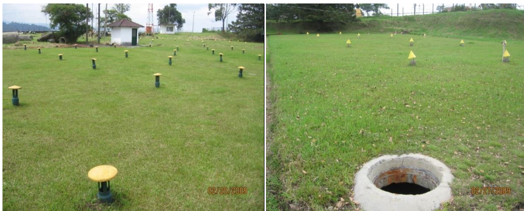
Figura 44. Tanques de almacenamiento
