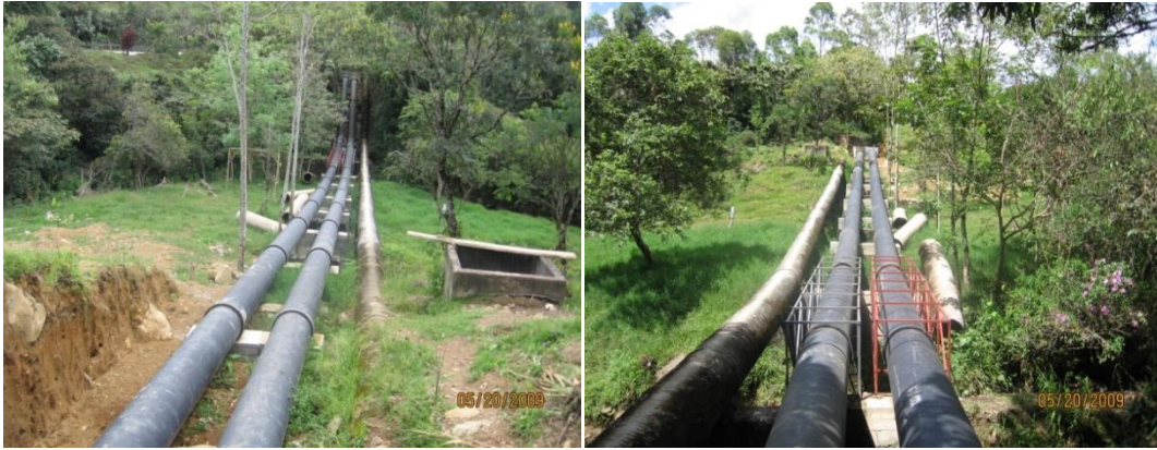
Figura 19. Tercer tramo de aducción con tubería nueva (HD)
