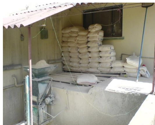
Figura 43. Sitio de almacenamiento de cal
