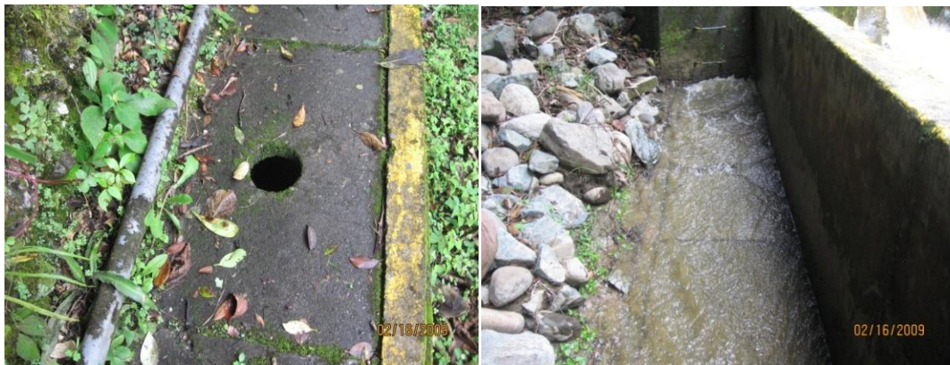
Figura 15. Canal de aducción entre la captación y los desarenadores
