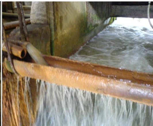
Figura 24. Dosificador de coagulante Figura 25. Aplicación en el punto de mezcla
