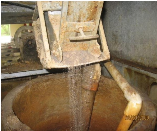
Figura 24. Dosificador de coagulante Figura 25. Aplicación en el punto de mezcla
