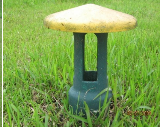
Figura 46. Ventilación del reservorio
