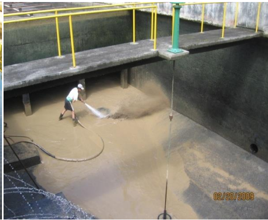
Figura 30. Operación de limpieza
