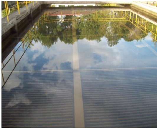
Figura 29. Sedimentador de placas
