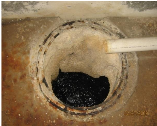
Figura 40. Punto aplicación de cal
