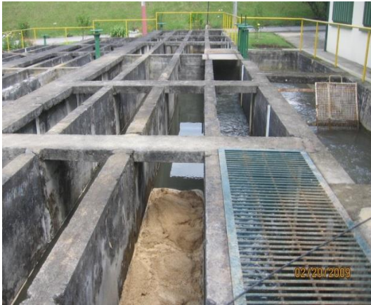
Figura 27. Floculadores hidráulicos
