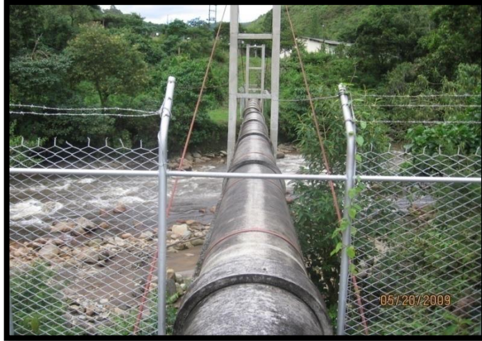
Figura 55. Primer tramo sin tubería alterna
