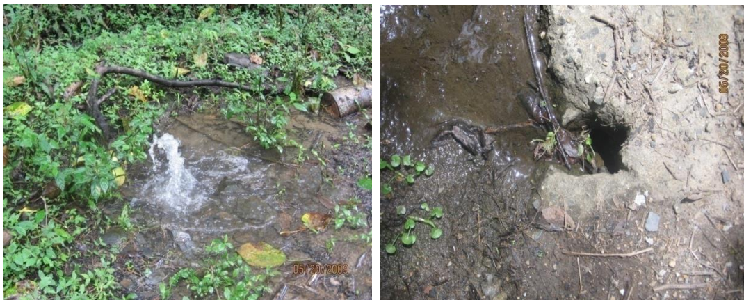
Figura 56. Daños en la estructura del primer tramo
