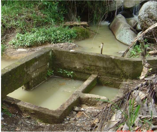
Figura 17. Bocatoma (Quebrada El Salero)
