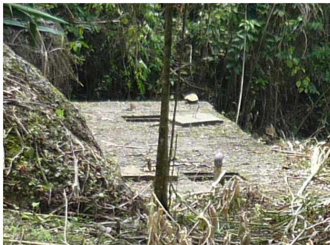
Figura 35. Desarenador convencional
