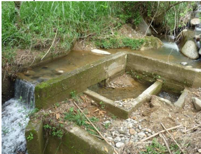
Figura 33. Bocatoma de tipo lateral
