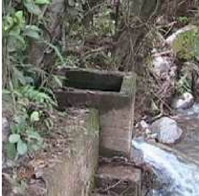
Figura 34. Cámara de quiebre
