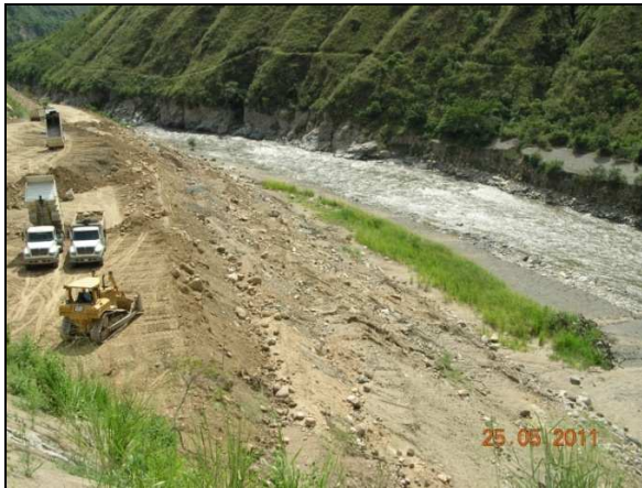
Escombrera del PR72+600
