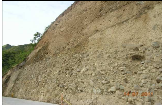
Figura 5. Talud en el PR65+090
