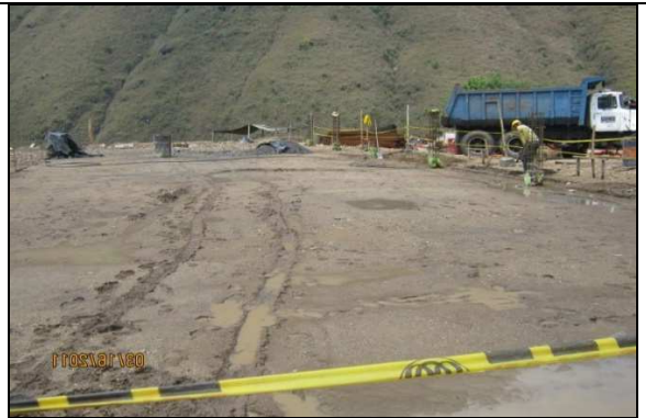
Adecuación del área sobre la que se construyó el taller y almacén de materiales
