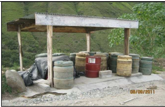
Almacenamiento adecuado de residuos considerados peligrosos provenientes del manejo de combustible
