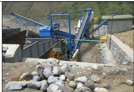
Área para la trituradora en el patio 2
