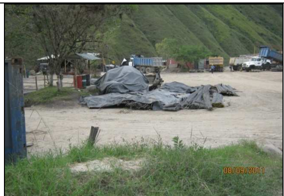
Material de hierro cubierto con un geotextil.
