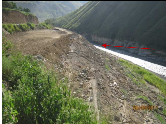
Conformación de terrazas Escombrera PR72+600
