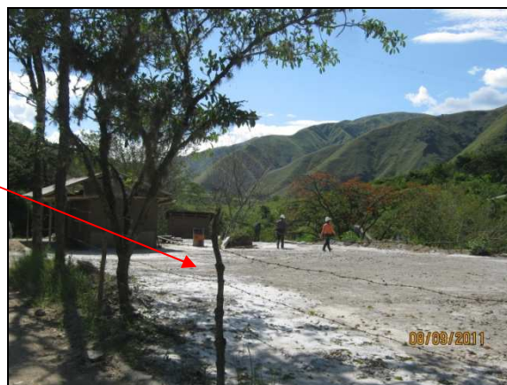
Escombrera PR68+650 mes de agosto
