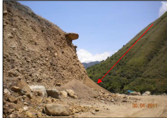
Figuras 13 y 14. Erosión en el Talud de la planta de concreto hidráulico PR73+180
