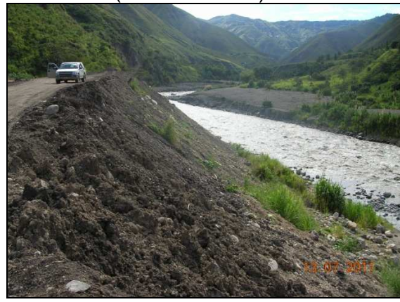
Figuras 31 y 32. Terraplén y Jarillón en el PR73+900 (vereda Patico)
