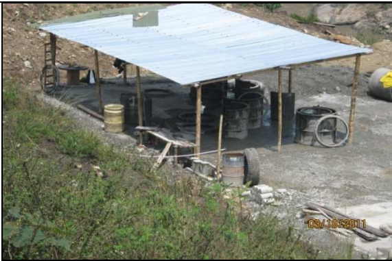
Área para la producción de tuberías en concreto
