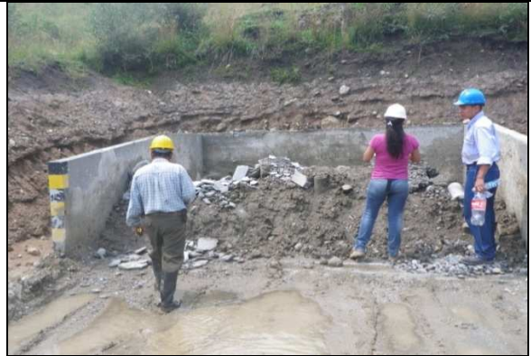
Área para el secado de lodos
