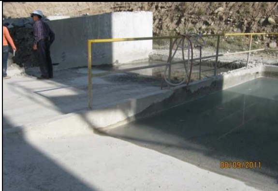
Sedimentador en buenas condiciones
