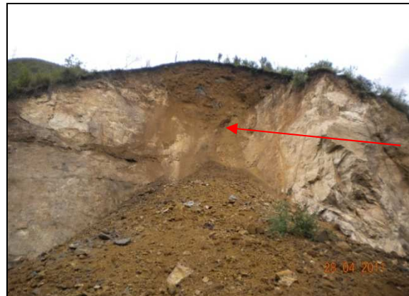
Figuras 15 y 16. Importantes muestra de inestabilidad en talud del PR67+550
