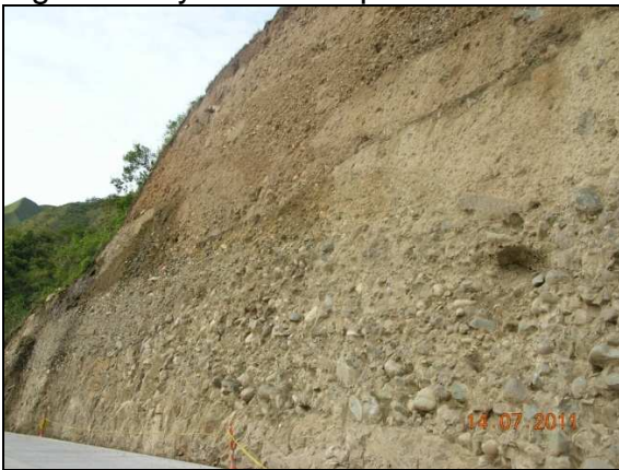
Talud por corte PR65+090
