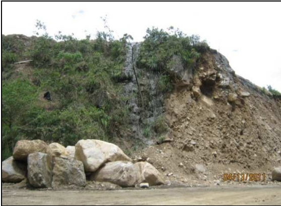
Figuras 13 y 14. Erosión en el Talud de la planta de concreto hidráulico PR73+180
