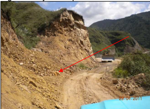
Figuras 15 y 16. Importantes muestra de inestabilidad en talud del PR67+550
