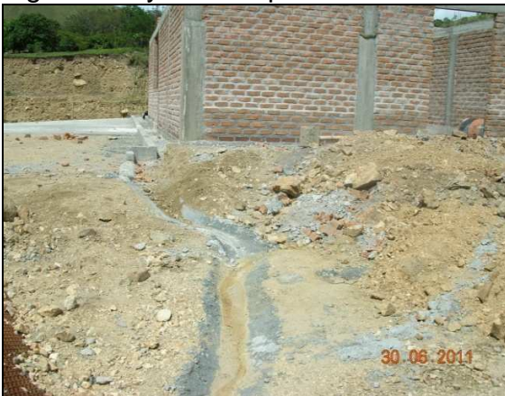
Adaptación de canaleta para manejo de aguas lluvias en la construcción del taller en La Planta Concreto y Trituración que escurren desde la Corona del Talud del PR73+180
