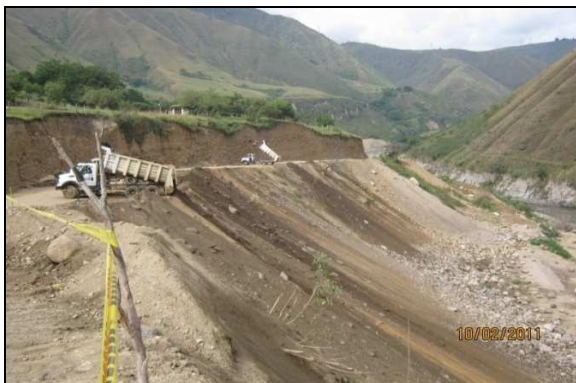
Figuras 8 y 9. Escombrera del PR72+600
