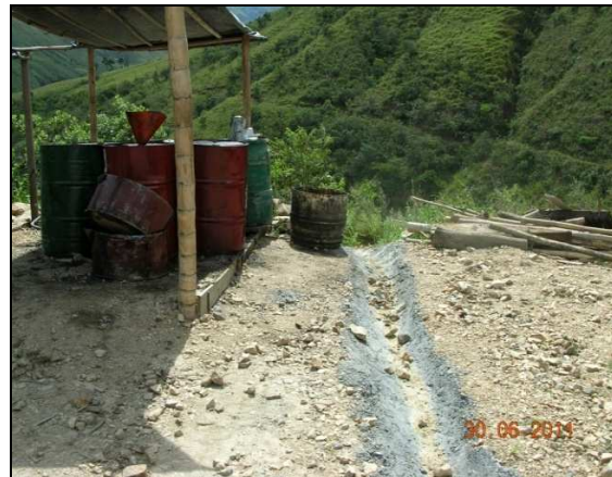
Adaptación de canaleta para manejo de aguas lluvias en la construcción del taller en La Planta Concreto y Trituración que escurren desde la Corona del Talud del PR73+180
