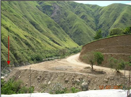
Lado que presenta pendiente lisa y pronunciada en la escombrera PR72+600
