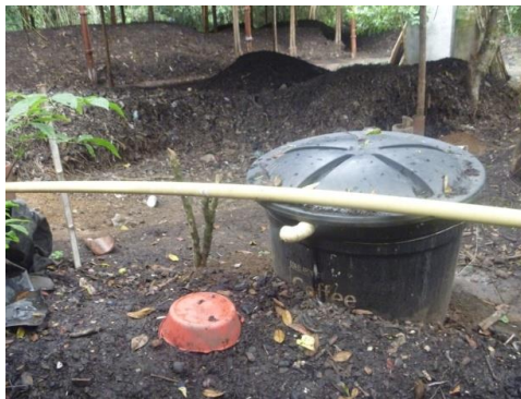
Figura 24. Tanque para almacenamiento de lixiviados, sin funcionamiento
