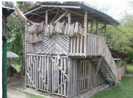
Figura 13. Utilización de iluminación natural en el beneficiadero
