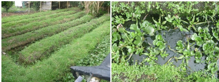
Figura 20. Piscina de oxidación cuarto tratamiento que reciben las aguas domésticas, tratamiento con buchón de agua, vista frontal y cercana.
