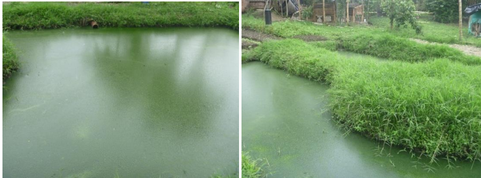
Figura 23. Laguna de oxidación, sexto tratamiento que reciben las aguas domésticas
