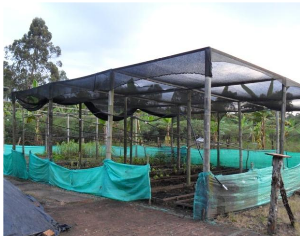
Figura 10. Cerca de lona verde deteriorada
