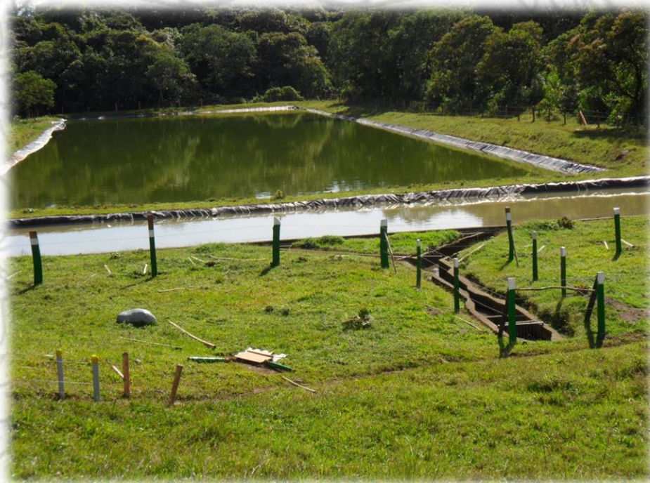
Fotografía 1: Cerramiento del sistema de lagunas
