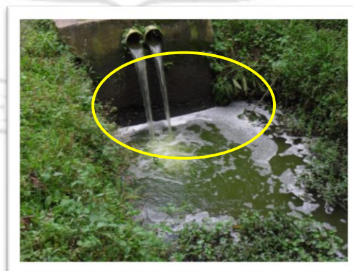
Fotografía 3: Salida del sistema de tratamiento
