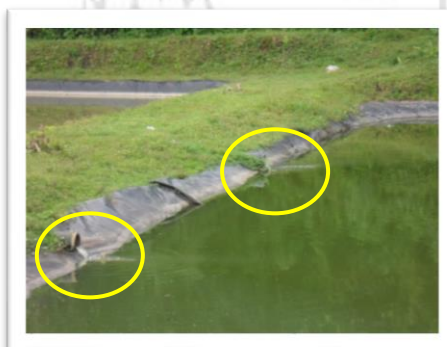
Fotografía 2: Entrada laguna facultativa
