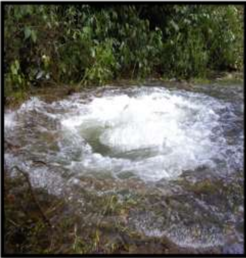
Figura 15. Tubería perforada tramo desarenador Piedras – captación Cauca
