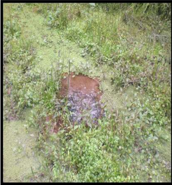
Figura 14. Tubería perforada tramo desarenador Piedras-captación Cauca
