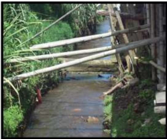
Pontón ubicado sobre la quebrada Pubús, tiene aproximadamente 40 años. Fuente: Propia del estudio
