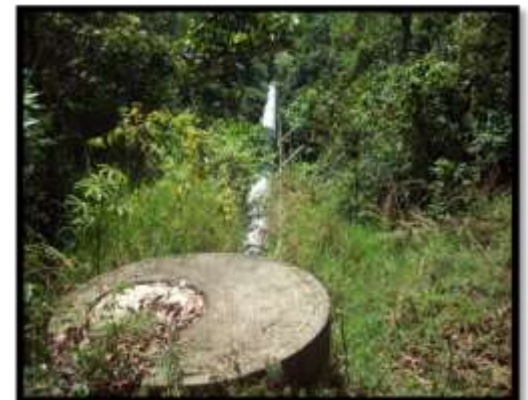
Viaducto de aproximadamente 25 metros
