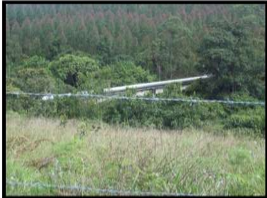
Viaducto de aproximadamente 35 metros ubicado en la vereda San Bernardino
