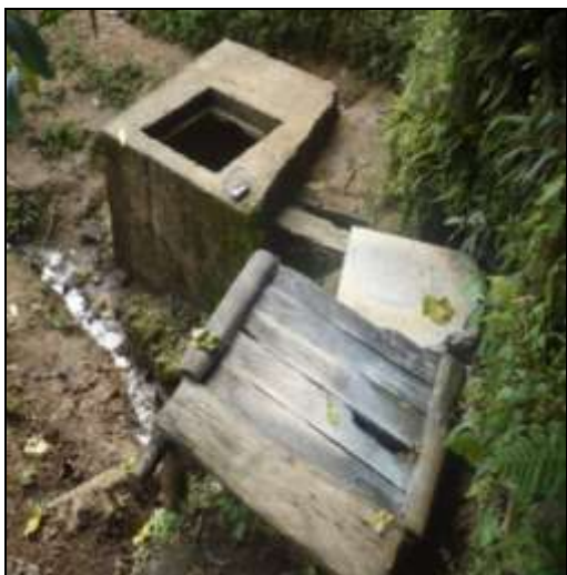
Figura 19. Primera cámara de quiebre destapada vereda Pomona
