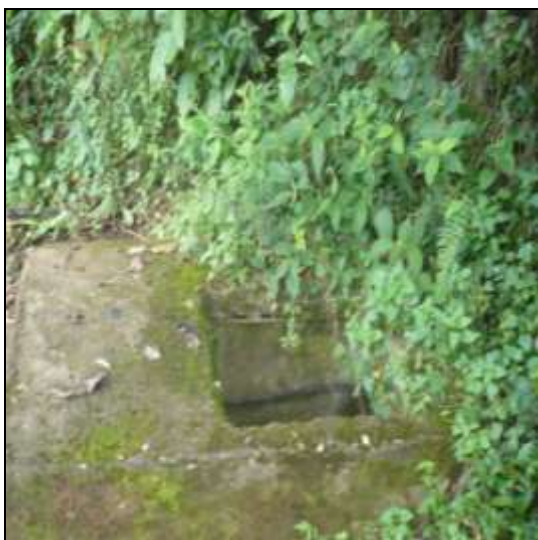
Figura 20. Segunda cámara de quiebre destapada vereda Pomona
