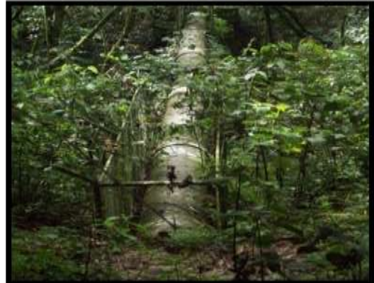
Viaducto de aproximadamente 25 metros ubicado en la vereda San Bernardino
