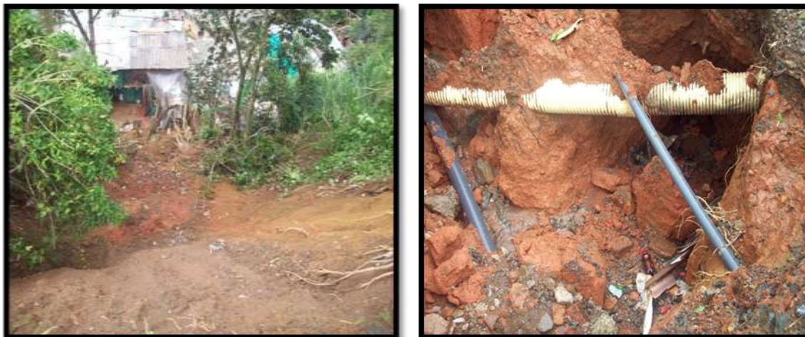
Figura 32. Deslizamiento en el Barrio Siloé
