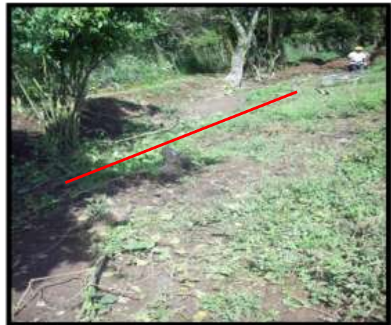
Barrio Antonio Nariño, el colector colapso debido a la filtración y raíces de un árbol
