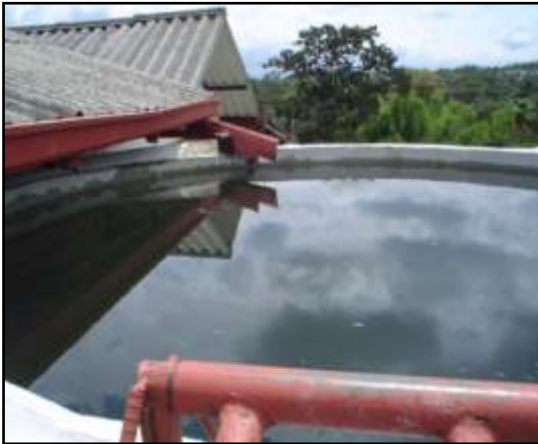
Figura 13. Almacenamiento de aguas lluvias
