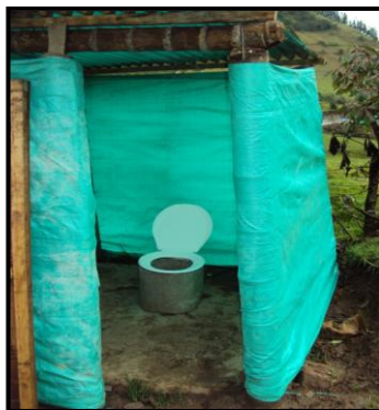
Figura 20. Instalación de letrina Coconuco y Paletará.
