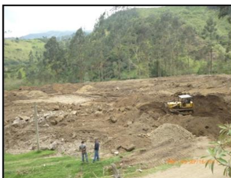
Figura 21. Trabajos de Compactación en la ZNT PR 28+ 650
