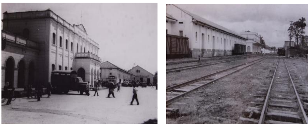
Foto 3. Antigua estación del tren
