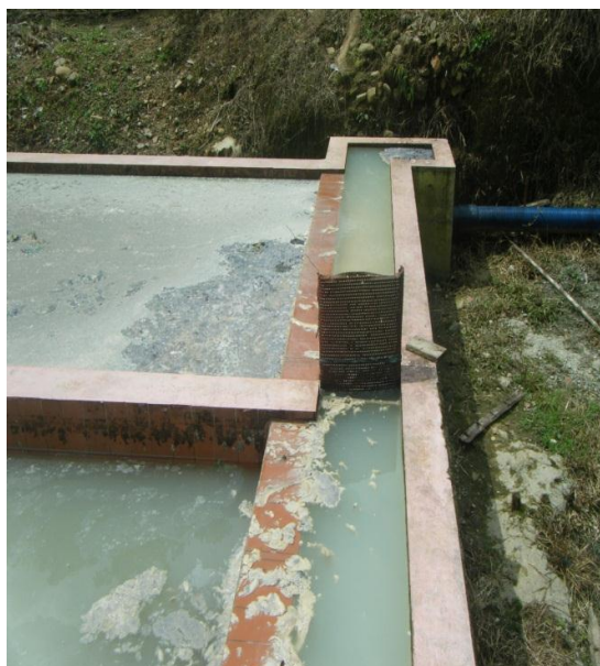
Foto 1. Entrada al sedimentador de mancha.
