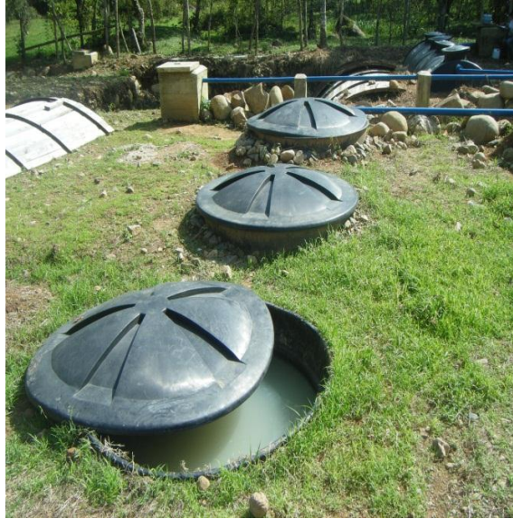
Foto 8. Tanques de sedimentación.
