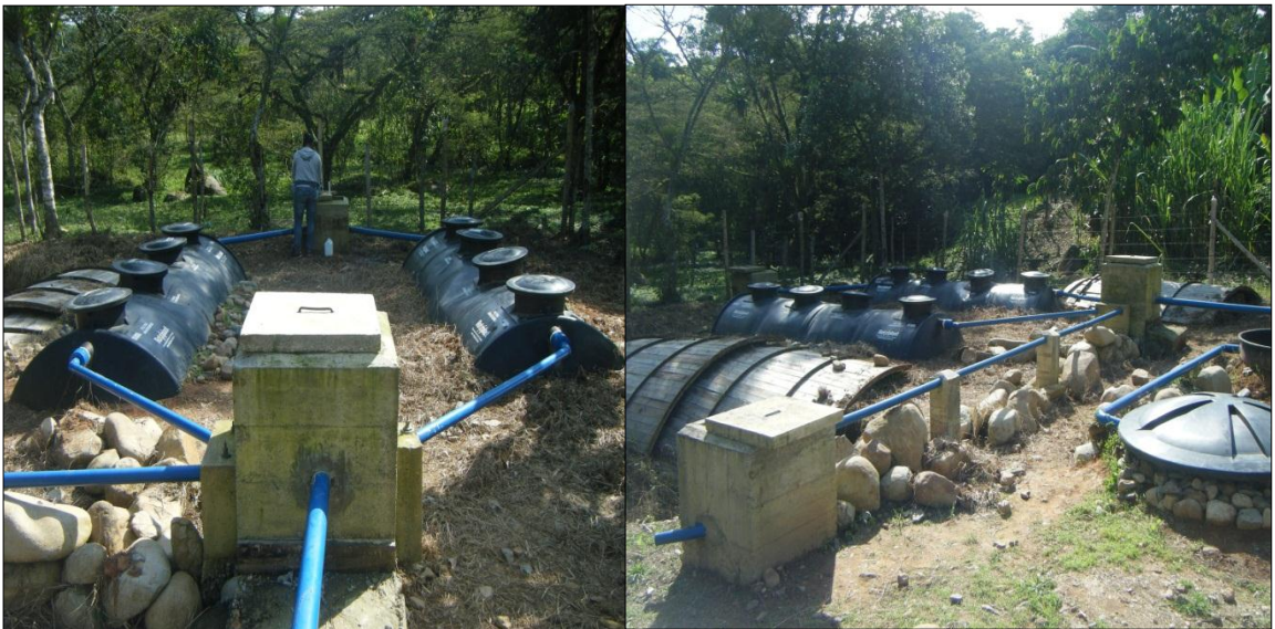
Foto 9. Filtros anaerobios.
