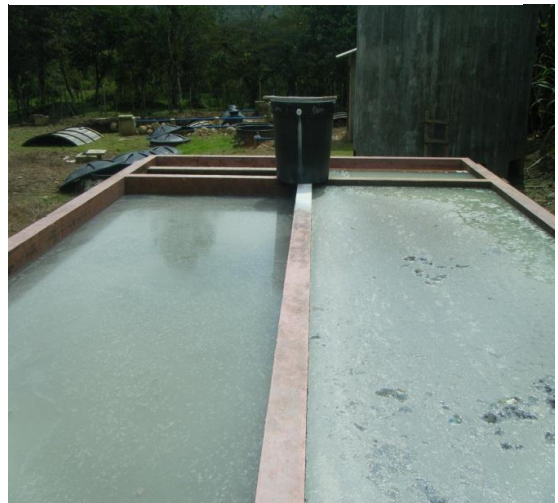
Figura 18. Diferencias entre los sedimentadores después del mantenimiento.
