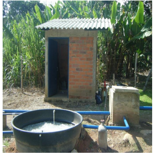
Foto 17. Caseta de equipos y almacenamiento.
