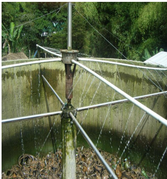
Foto 14. Brazo distribuidor del filtro percolador.
