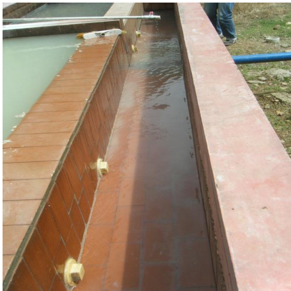
Foto 4. Dosificación de cal.
