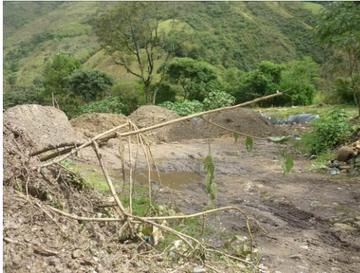
Figura 11. Estancamiento de lixiviado y agua lluvia.
