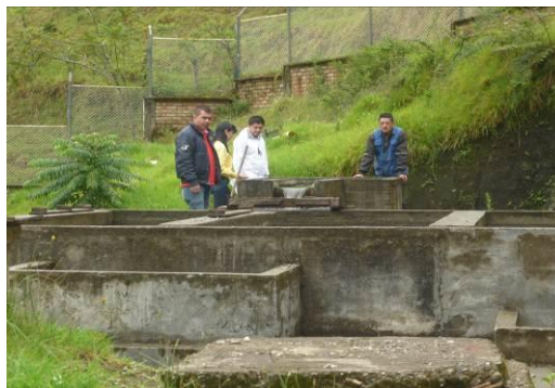
Figura 12. Planta de tratamiento de agua potable PTAP, La Vega-Cauca.
