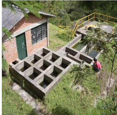
Figura 3. Planta de potabilización de agua- Coconuco.
