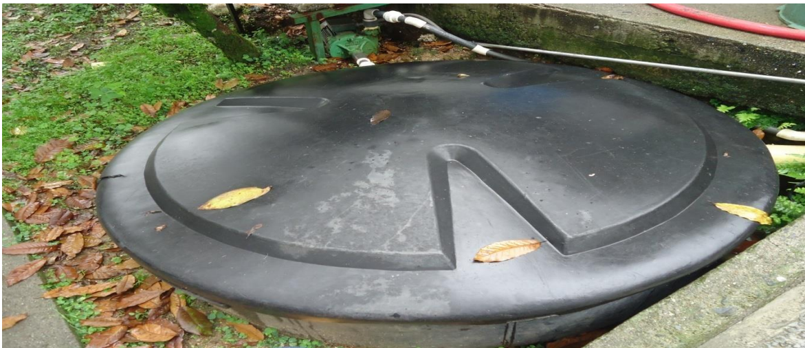
Ilustración 8. Tanque de almacenamiento para el lixiviado de los lechos de secado
