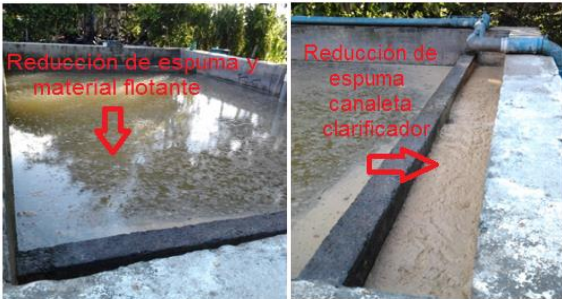
Ilustración 22. Reducción de material flotante y espuma en el clarificador secundario
