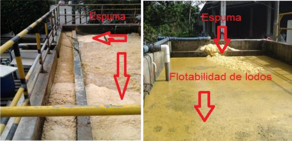
Ilustración 12. Presencia de espuma en el reactor y sedimentador
