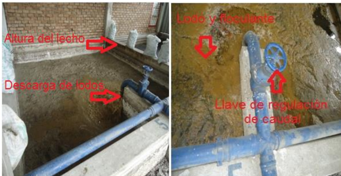
Ilustración 33. Descarga del floculante en el lecho número 5
