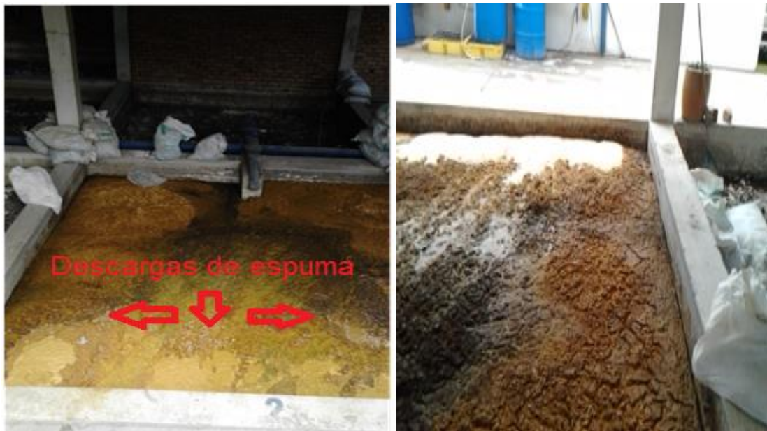
Ilustración 35. Descarga de espuma en los lechos de secado
