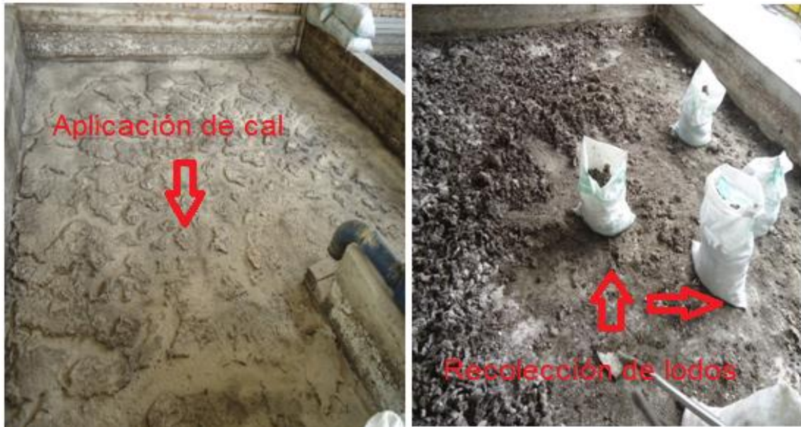
Ilustración 34. Aplicación de cal y recolección de lodo deshidratado
