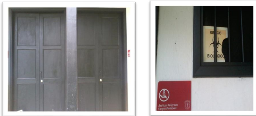
Figura 17. Falta de señalización en área de almacenamiento de residuos.
