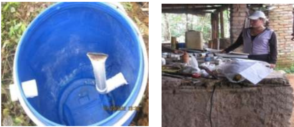
Figura 9. Instalación de trampa de pulpas en la vereda Los Cerrillos.
