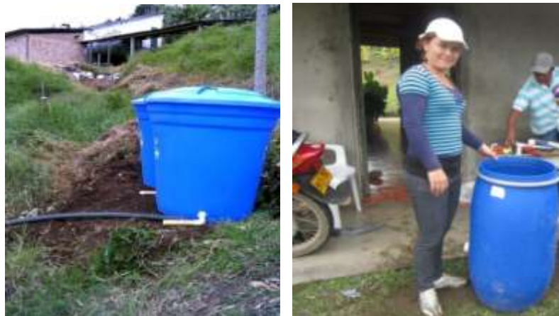
Figura 12. Instalación del SMTA en la vereda La Calera
