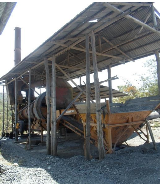
Planta de mezcla asfáltica
