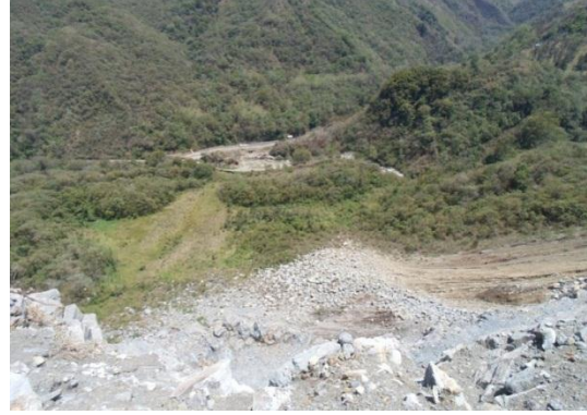
Residuos de material inservible, al fondo se observa la bocatoma y canal de conducción de la hidroeléctrica Florida II
