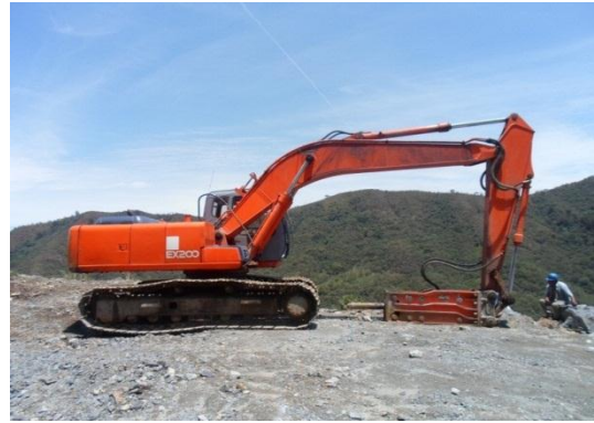
EX200-S con Martillo Hidráulico para golpear la piedra
