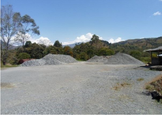
Material de piedra filtro y pasante respectivamente
