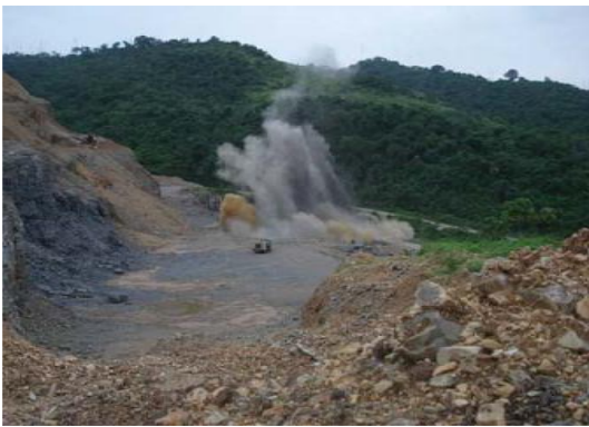
Detonación controlada de material con explosivo Indugel
