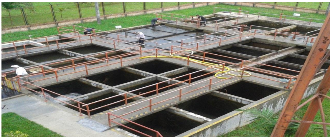
Figura 1. Planta N° 2 del sistema de tratamiento, capacidad 120 L/s.
