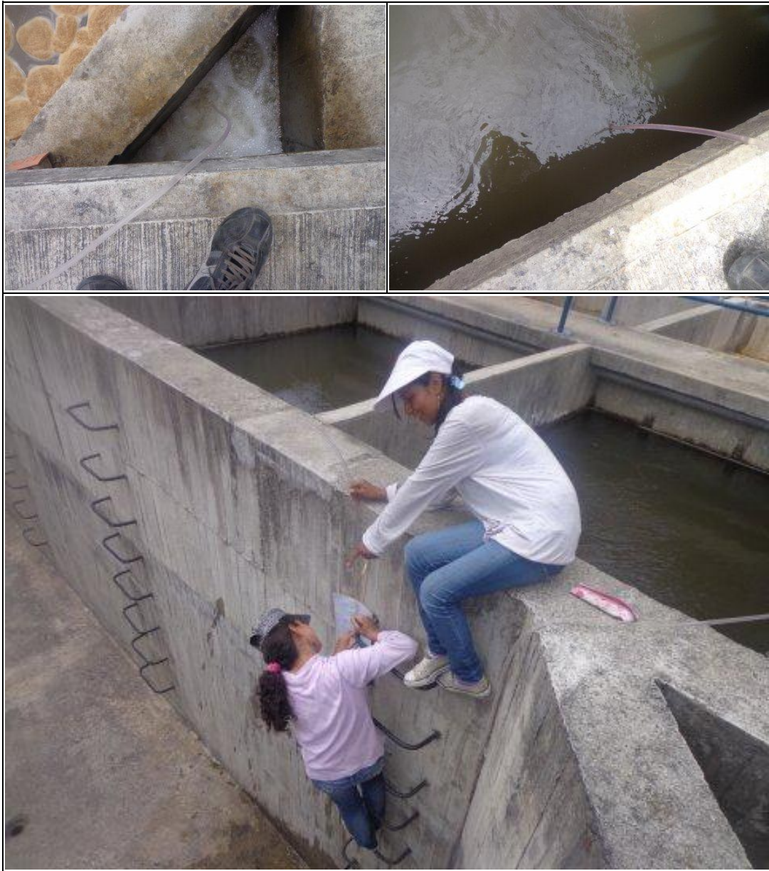
Figura 11. Medición de niveles de agua en los compartimientos de los floculadores
