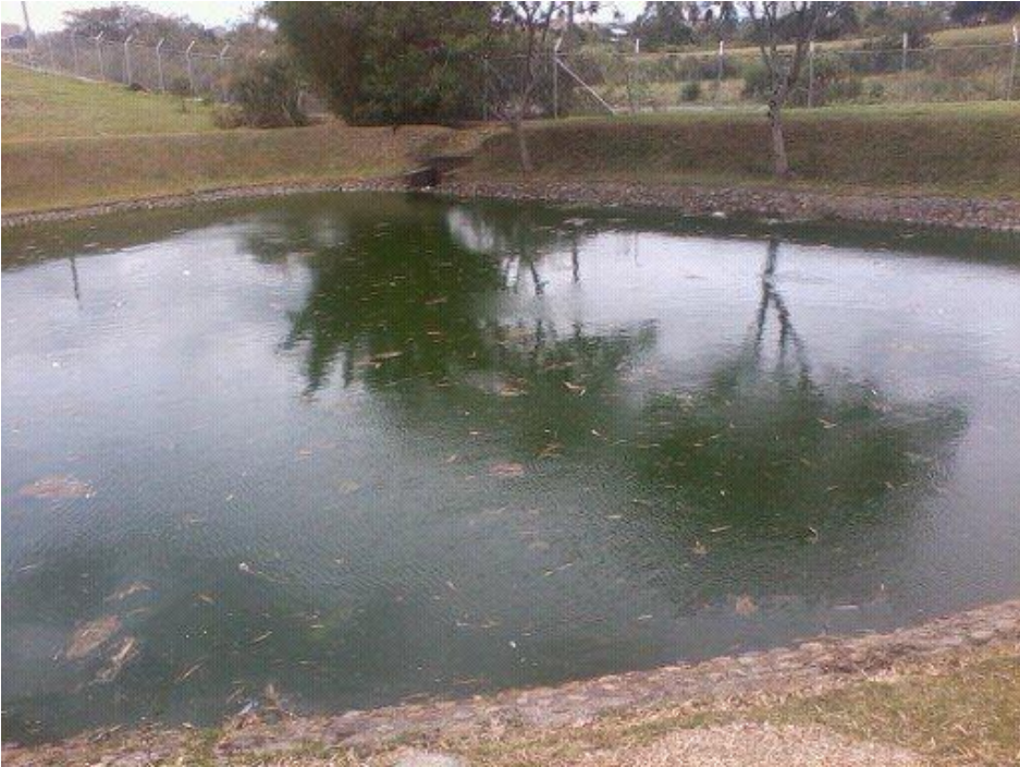
Imagen A3.7. Laguna de maduración.
