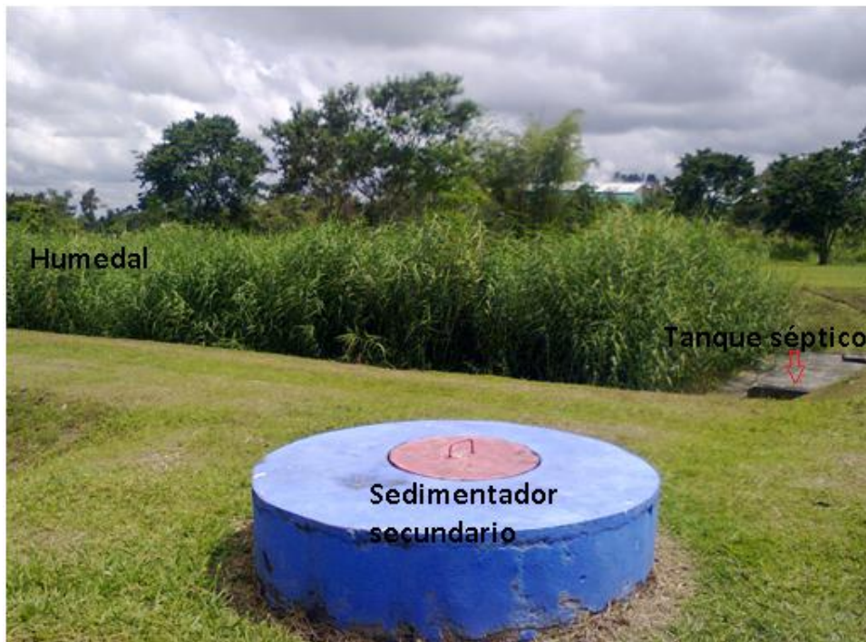
Imagen A3.6. Sedimentador secundario, tanque séptico y humedal de flujo subsuperficial.
