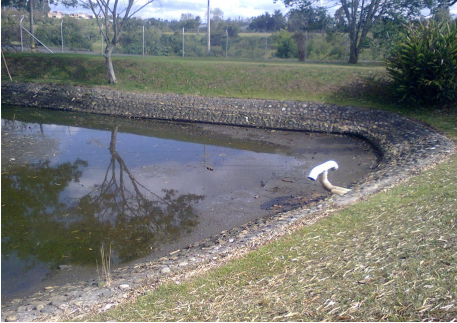
Imagen A3.7. Laguna de maduración entrada.
