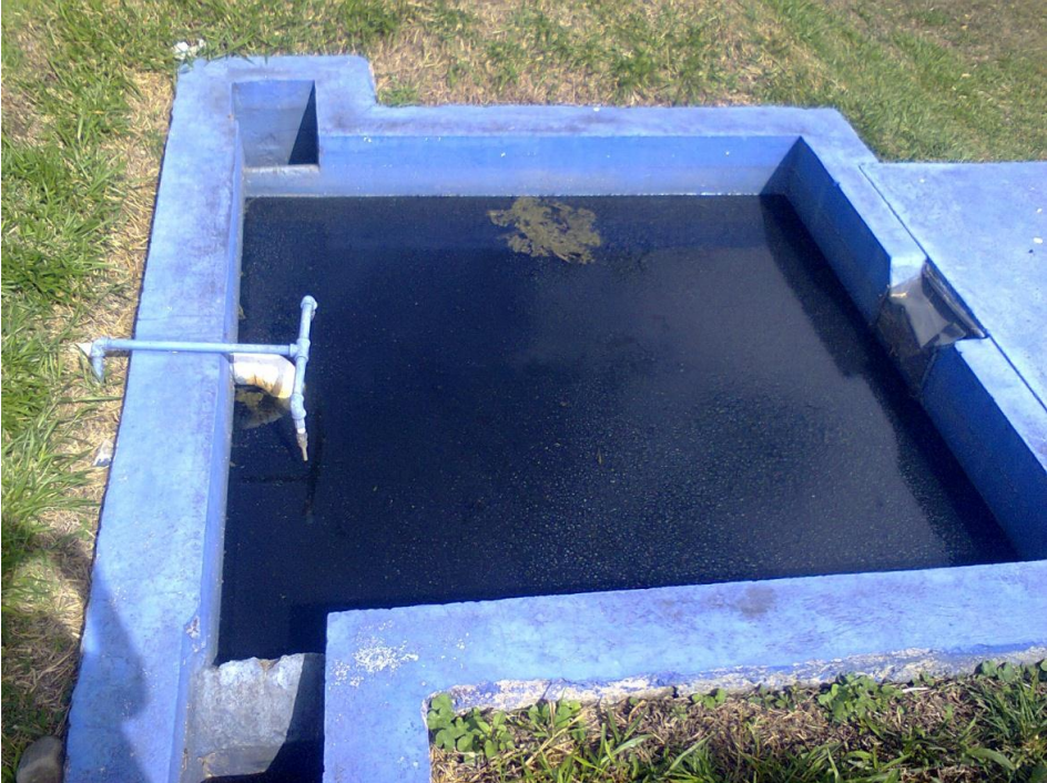
Imagen A3.2. Tanque homogeneizador.
