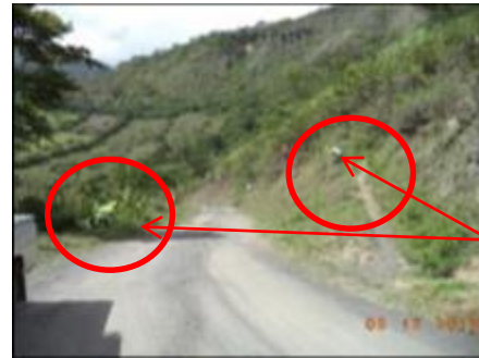
Figura 18. Desmonte del terreno natural.
