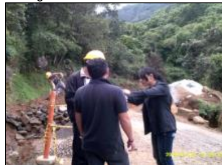
Figura 39. Capacitación con el personal encargado en el frente de obra.
