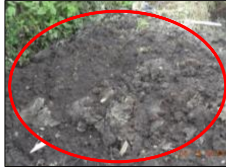
Figura 10. Material sobrante dispuesto sobre la vía pública.
