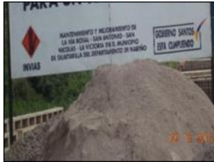
Figura 17. Material de obra sin cubrir.
