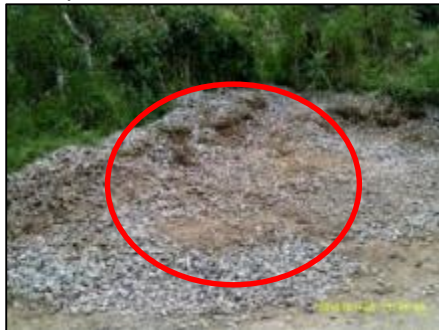
Figura 36. Material de construcción sobre la vía pública.
