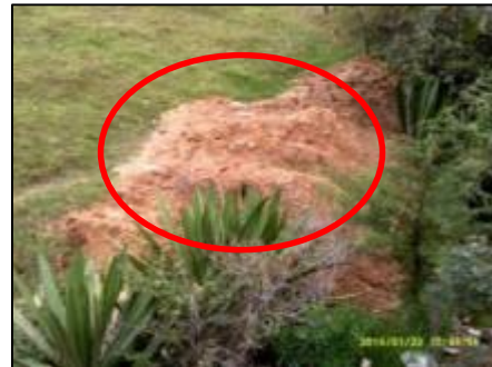
Figura 37. Material producto de las excavaciones, sin conformar.
