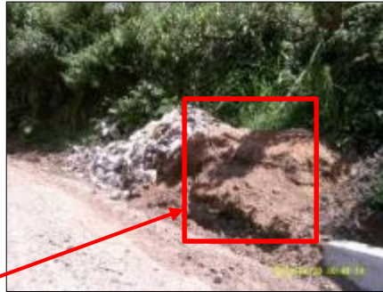
Figura 28. Disposición de material de excavación las orillas de la vía pública.
