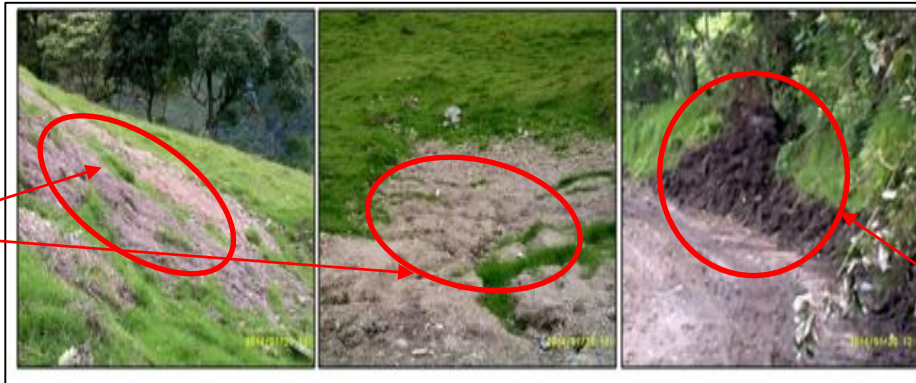
Figura 46. Material sobrante sobre la pendiente y vía pública
