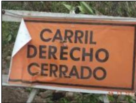
Figura 15. Señalización en el frente de obra.
