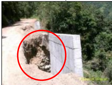
Figura 26. Áreas de trabajo sin la debida demarcación y señalización.
