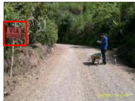
Figura 23. Señalización informativa en el frente de obra.
