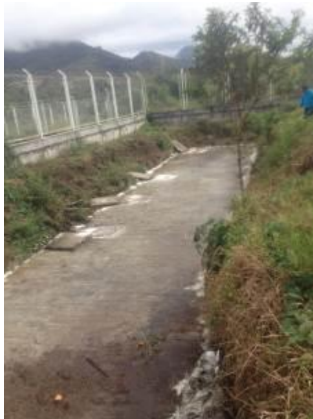
Figura 2. Pozo séptico, para tratamiento de aguas residuales
