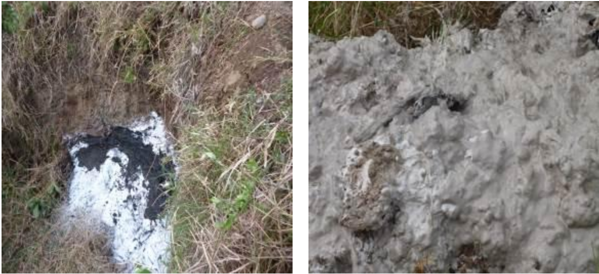
Figura 28 y 29. Preparación de los huecos y disposición final de los lodos provenientes del lavado final de la parte exterior del pozo séptico.
