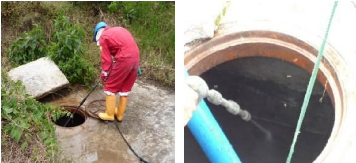
Figura 22 y 23. Lavado y desinfección del interior del pozo séptico.
