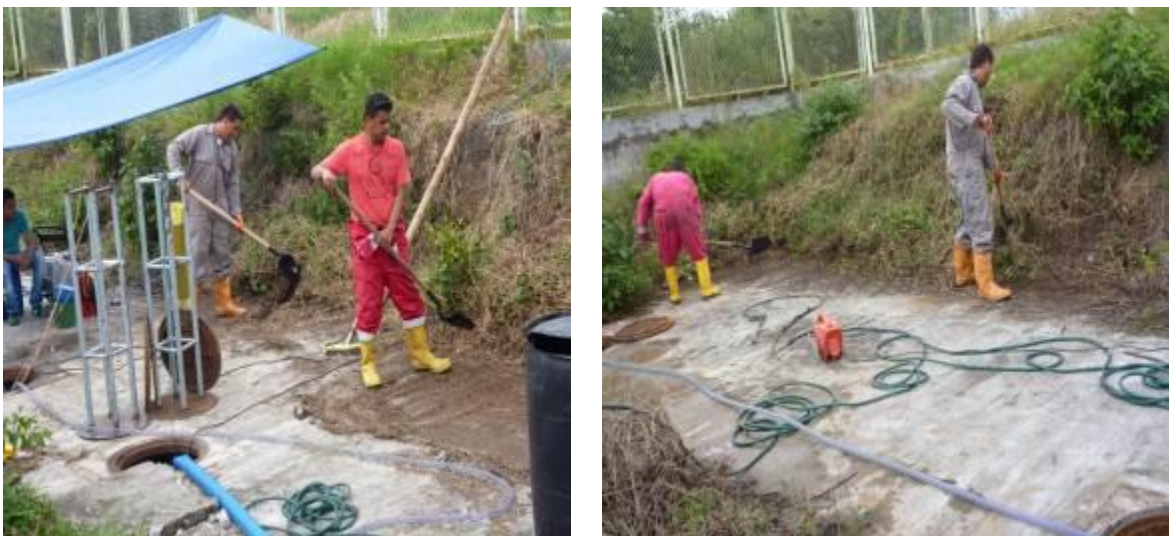
Figura 15 y 16. Extracción de los líquidos de las cámaras de sedimentación 1 y 2 – por medio de bombeo – a la tubería perforada de la cámara de filtración.
