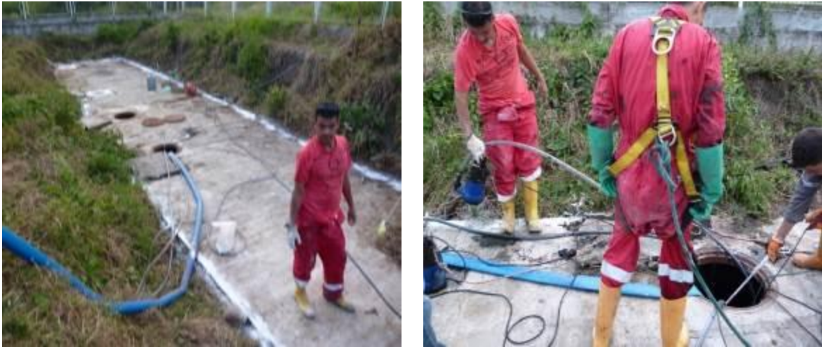
Figura 15 y 16. Extracción de los líquidos de las cámaras de sedimentación 1 y 2 – por medio de bombeo – a la tubería perforada de la cámara de filtración.
