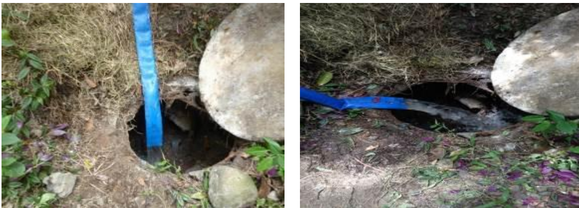
Figura 11 y 12. Disposición final de los líquidos ya tratados y descontaminados (en colector del sistema de alcantarillado del municipio).
