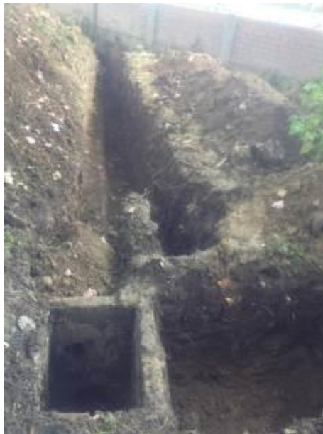
Figura 1. Obras para ampliación de cajilla de inspección y cambio de tuberías de aguas residuales domésticas.
