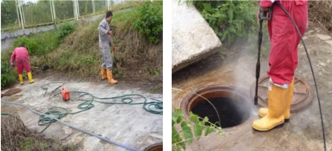
Figura 26 y 27. Lavado exterior del pozo séptico (tapa superior).
