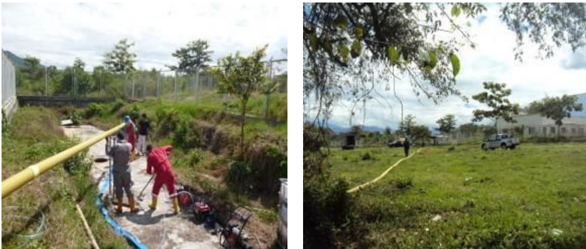
Figura 11 y 12. Disposición final de los líquidos ya tratados y descontaminados (en colector del sistema de alcantarillado del municipio).
