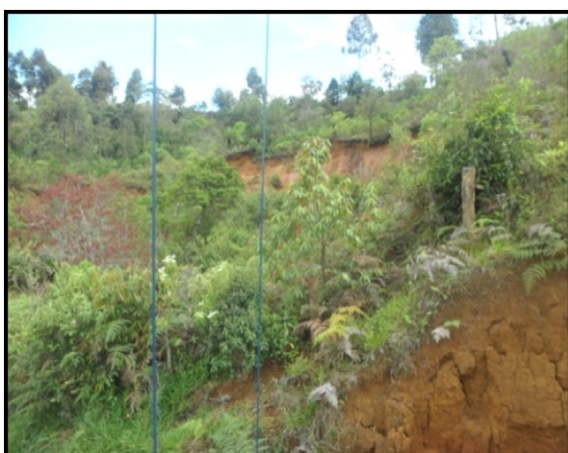
Tramos contruidos en taludes de baja altura con materiales finos limo-arcillosos.
