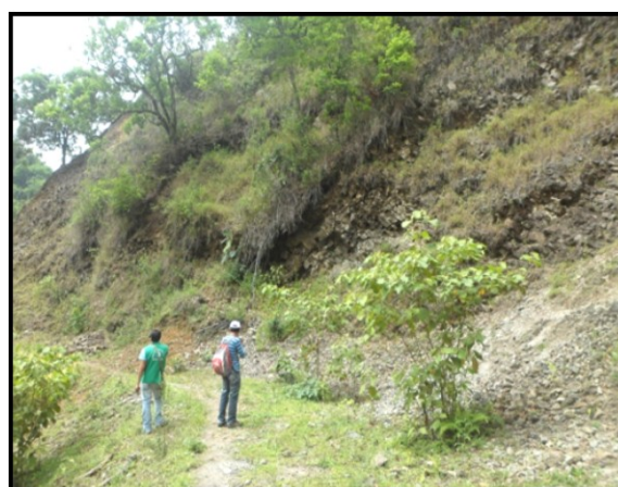
Tramos con zonas húmedas y material rocoso sin compactar.
