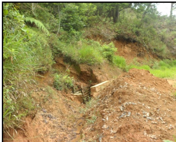
Tramos contruidos en taludes de baja altura con materiales finos limo-arcillosos.
