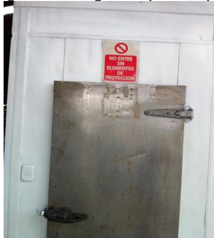
Figura 33. Refrigerador para Respel
