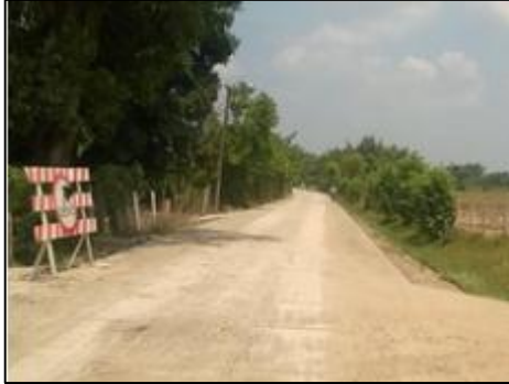
Figura 18. Vía con la respectiva señalización y finalizando la etapa de limpieza y entrega de la misma.
