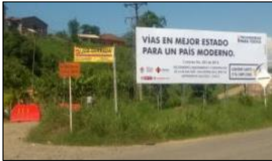
Figura 26. Inicio de obra y señalización pertinente.
