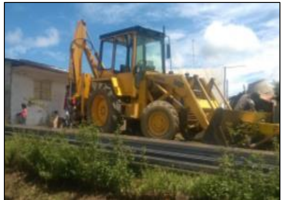
Figura 37. Predio donde se guarda la maquinaria y bodega de materiales.
