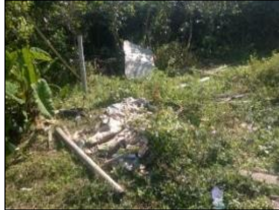
Figura 43. Residuos convencionales de obra en el mismo predio privado. Y material sobrante de descapote y daños al predio.
