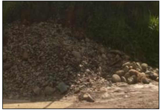
Figura 47. Residuos convencionales y sobrantes de obra obstruyendo una alcantarilla.
