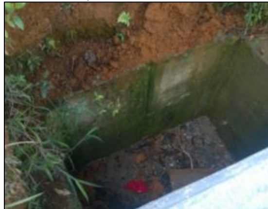
Figura 47. Residuos convencionales y sobrantes de obra obstruyendo una alcantarilla.
