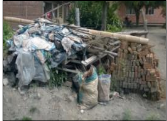
Figura 25. Material sobrante de obra sin su debido manejo integral.
