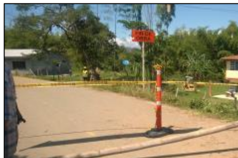
Figura 31. Señalización y acordonamiento al final de la obra.
