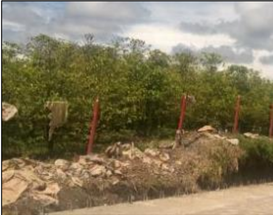
Figura 38. Material sobrante de obra dispuesto sobre un predio aledaño sin su disposición ni manejo debido.
