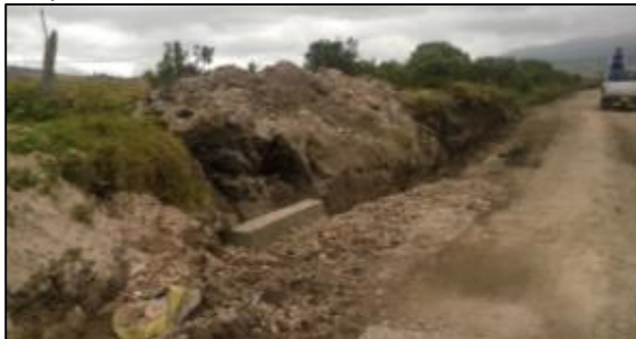
Figura 11. Material sobrante dispuesto sobre la vía pública.
