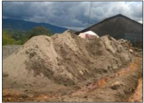
Figura 35. Material de obra sin su debido manejo integral ni acordonamiento.
