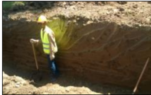
Figura 27. Personal de obra con el equipo de protección personal correspondiente.
