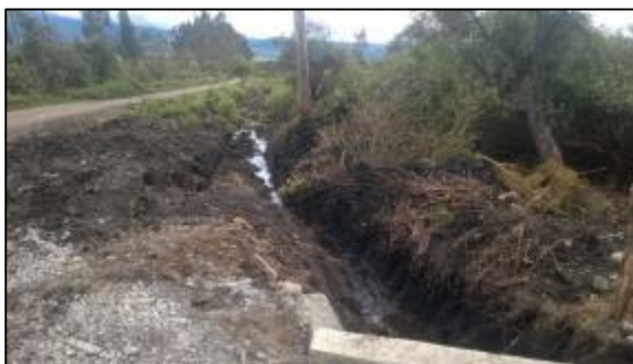
Figura 13. Material sobrante producto del desmonte del terreno natural.
