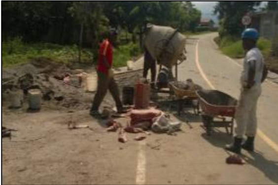
Figura 16. Personal de obra con elementos de protección personal
