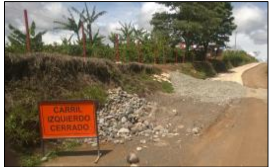
Figura 35. Material de obra sin su debido manejo integral ni acordonamiento.
