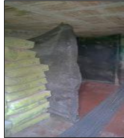
Figura 10. Bodega de materiales.
