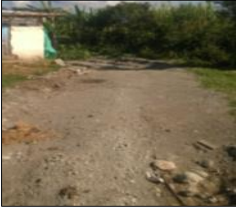
Figura 42. Afectación de predio privado debido a una vía alterna usada por el personal de obra.
