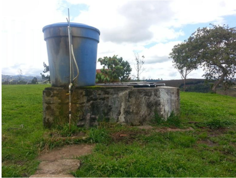
FOTOGRAFÍA A4. 10. RECUPERACIÓN DEL TANQUE PARA FILTRACIÓN LENTA
