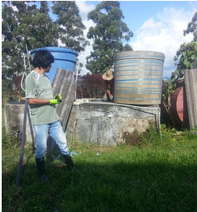
FOTOGRAFÍA A4. 11. ADAPTACIÓN DEL TANQUE PARA FILTRACIÓN LENTA
