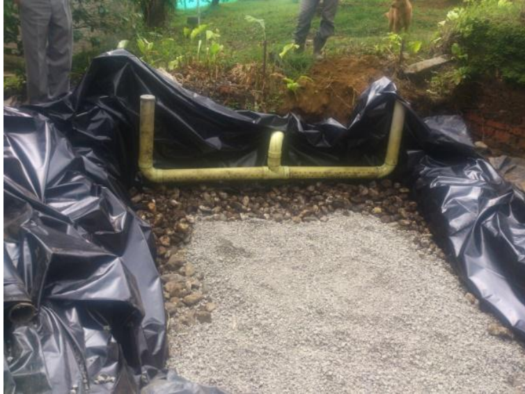
FOTOGRAFÍA A4. 6. IMPERMEABILIZACIÓN Y LLENADO CON GRAVA
