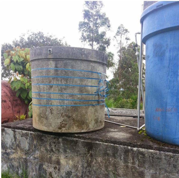
FOTOGRAFÍA A4. 10. RECUPERACIÓN DEL TANQUE PARA FILTRACIÓN LENTA
