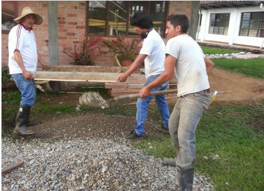
FOTOGRAFÍA A4. 13. TAMIZADO DE LA GRAVA
