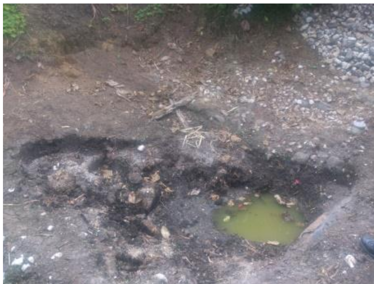
FOTOGRAFÍA A4. 5. EXCAVACIÓN DEL HUMEDAL
