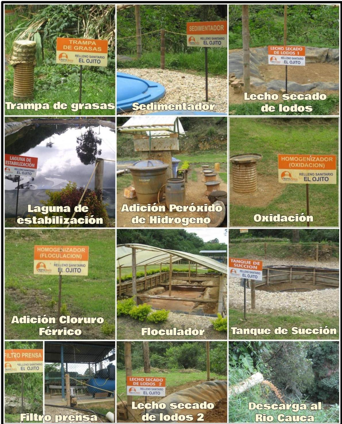
Figura 1. Sistema de tratamiento de lixiviados Relleño Sanitario "El Ojito"
