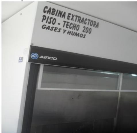
Figura 65. Campana de extracción Laboratorio de Química
