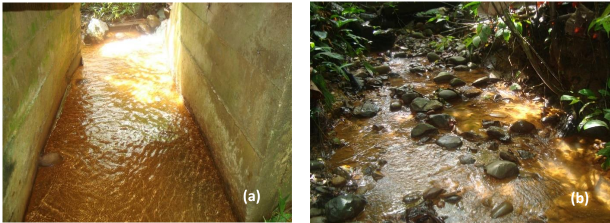
Figura 4.31 Quebrada Jiménez (a) paso por un Box Culvert y (b) después del Box Culvert, Territorio de Córdoba
