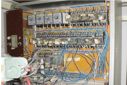
Figura 23. Circuito de control del Autoclave Gembloux 110 lt
