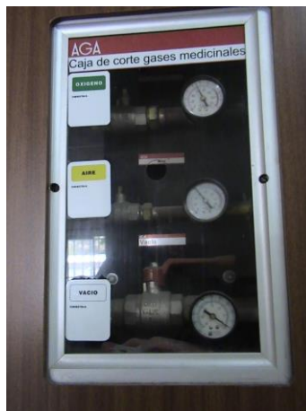
Figura 4. Fotografía de una caja de corte del Hospital S.L.V.
