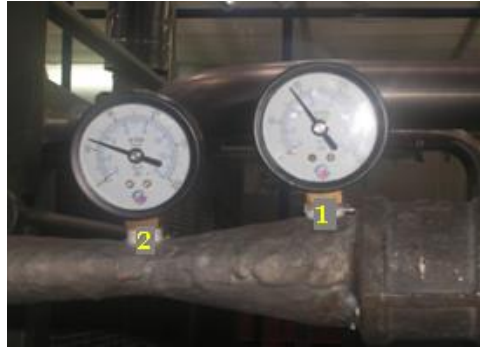
Figura 5.6. Medida de presión con el dispositivo Venturi
