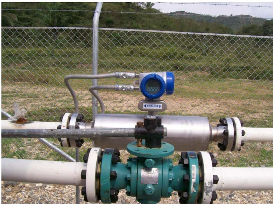
**Imagen 13:** Medidor de flujo ultrasónico instalado en el pozo Don Pedro.
