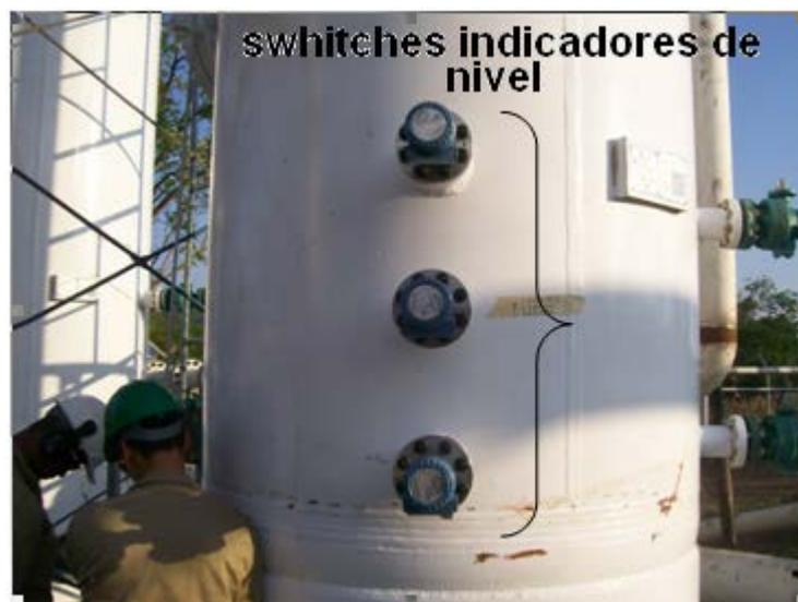
**Imagen 9:** switches indicadores de alarma de nivel, ubicados en los scrubbers
