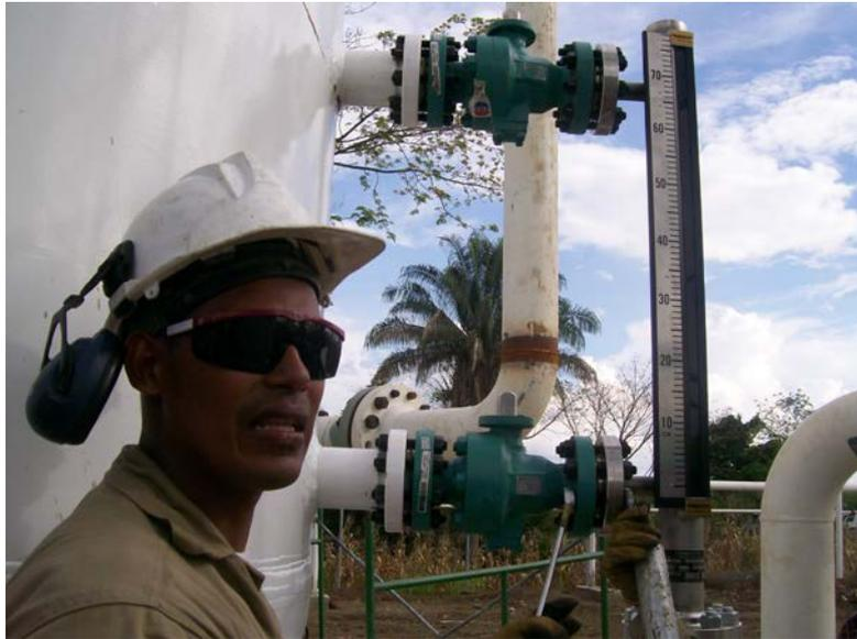
**Imagen 8.** Montaje del indicador de nivel en uno de los colectores de húmedos
