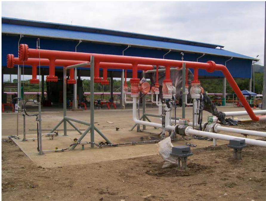
**Imagen 4:** Sistema de Manifolds de recibo
