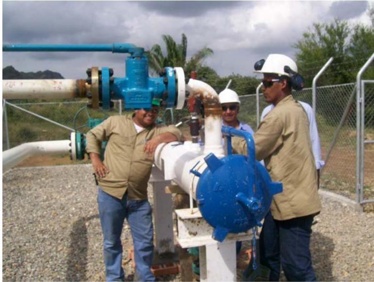
**Imagen 2:** Sistema trampa de marrano del pozo Monserrate (Ortega Tolima)
