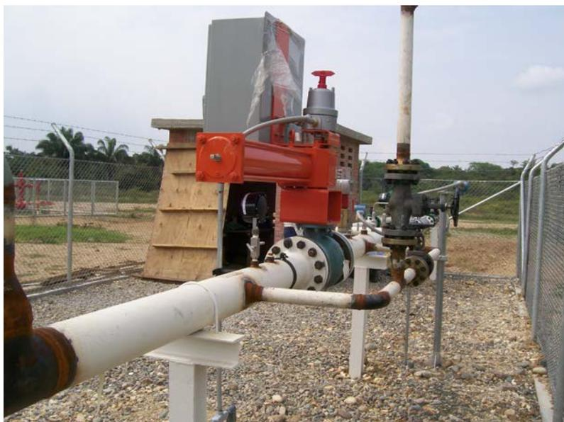
**Imagen 11:** Válvula de emergencia ESDV instalada en el pozo Don Pedro
