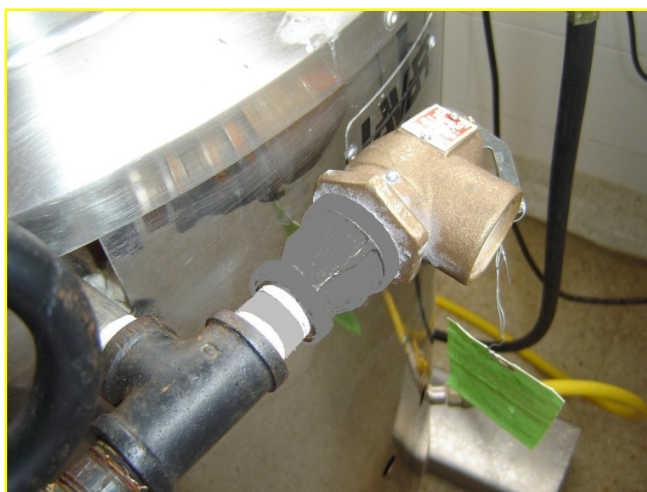
Figura 29. Válvula de seguridad de vapor NUEVA
