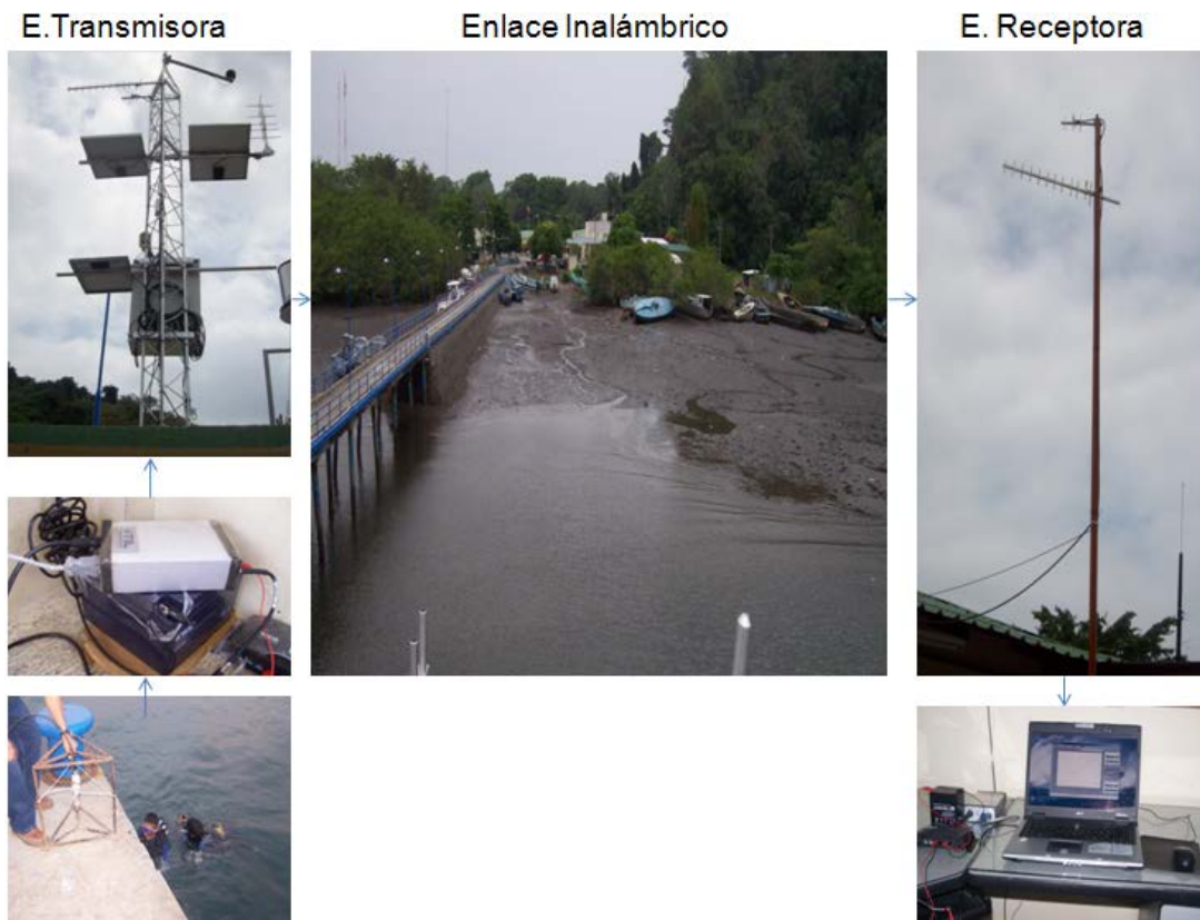
Figura 36. Instalación final del sistema de telemetría
