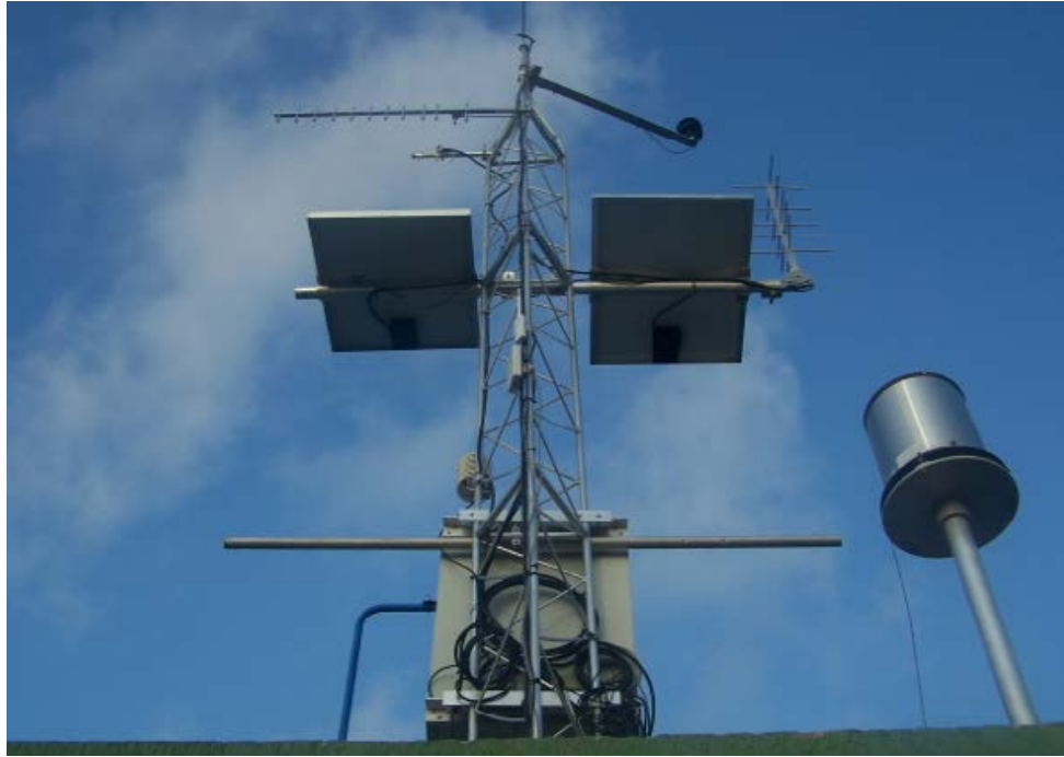
Figura 32. Instalación definitiva de los paneles solares, baterías y reguladores de voltaje en la estación transmisora
