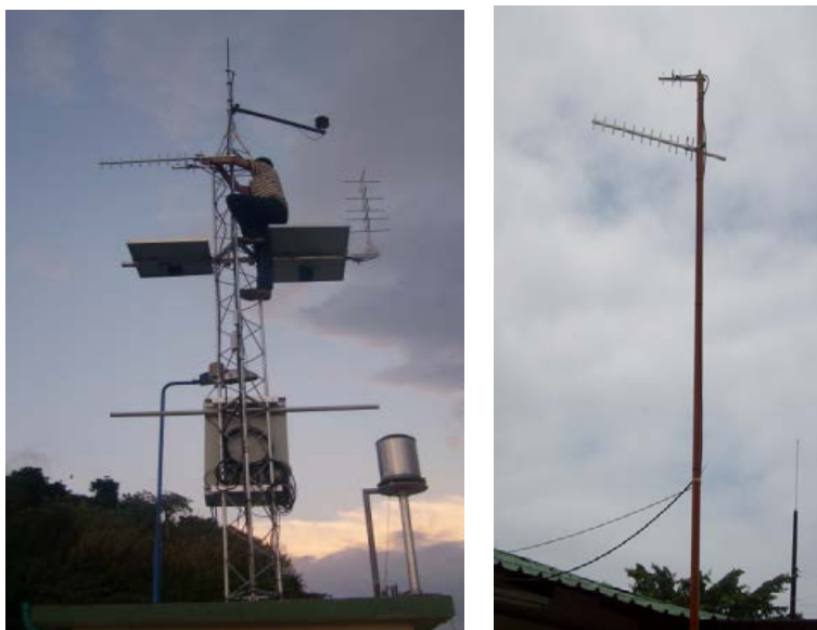
Figura 26. Instalación final de antenas y dispositivos de comunicación
