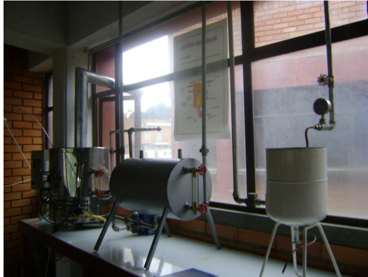
Fig. 2. Caldera pirotubular del laboratorio de Ingeniería Industrial.
