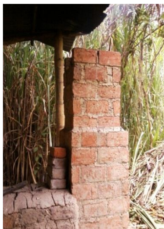
Figura 4.6. Chimenea de la hornilla panelera
