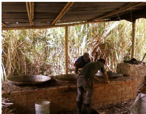
Figura 4.5. Ducto de humos de la hornilla panelera
