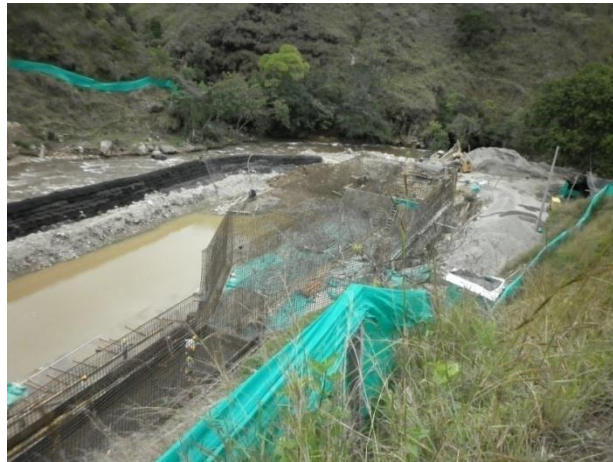
Figura 3.28 – Fotografía de la construcción de la bocatoma para el distrito de riego Tesalia Paicol. 2010.
