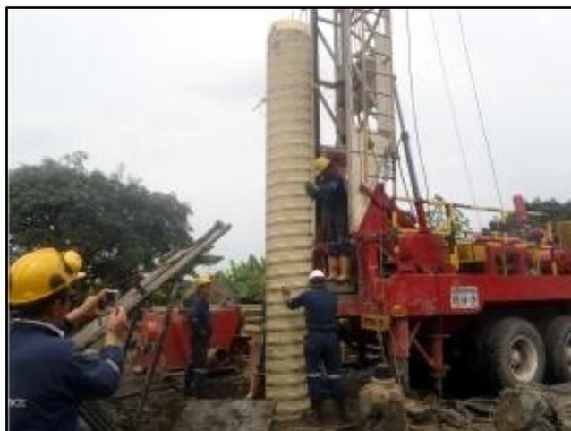
**Figura 4.8.** Proceso de introducción de la tubería
