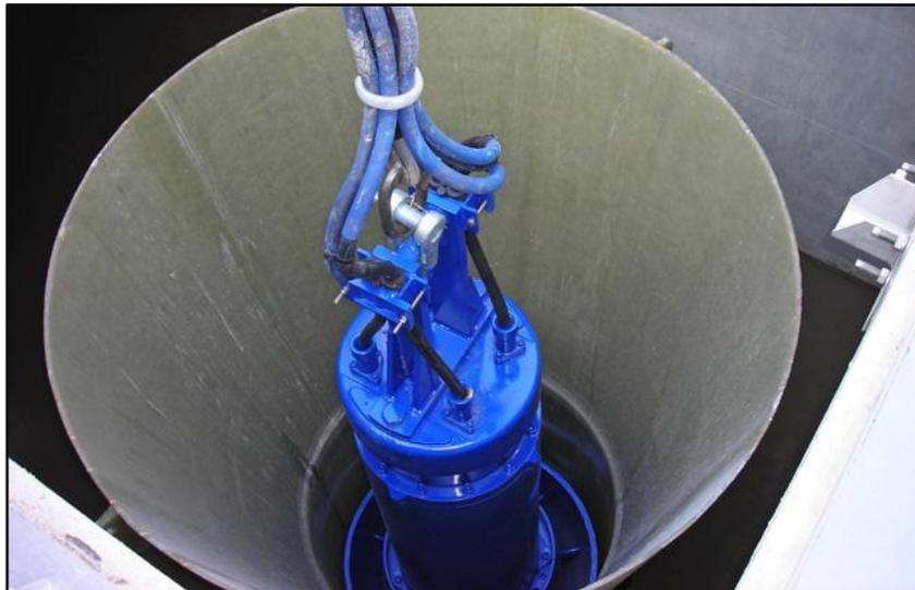
**Figura 4.12.** instalación de una bomba dentro de un pozo de aguas subterráneas por Colpozos.
