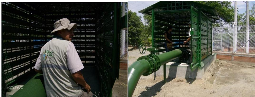
**Figura 6.10.** Pozo en La Serafina, Puerto Tejada (Cauca). (a) Funcionario de la CRC en inspección previa a la expedición del permiso de funcionamiento del pozo. (b) Tubería dirigida del pozo al campo de riego.
