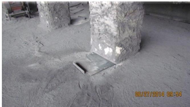
Figura 4.6. Escotilla de inyección abierta.
