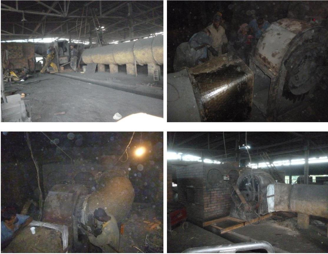
Figura 4.5. Conexión del ventilador al ducto.
