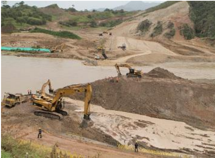
Imagen 2. Construcción de la represa El Quimbo, Huila, Colombia. Se destinarán casi 9000 hectáreas de terreno para la construcción del embalse y producirá 400MW, el 4% de la potencia consumida por Colombia en la actualidad. La oposición a este proyecto ha suscitado una importante movilización nacional.
