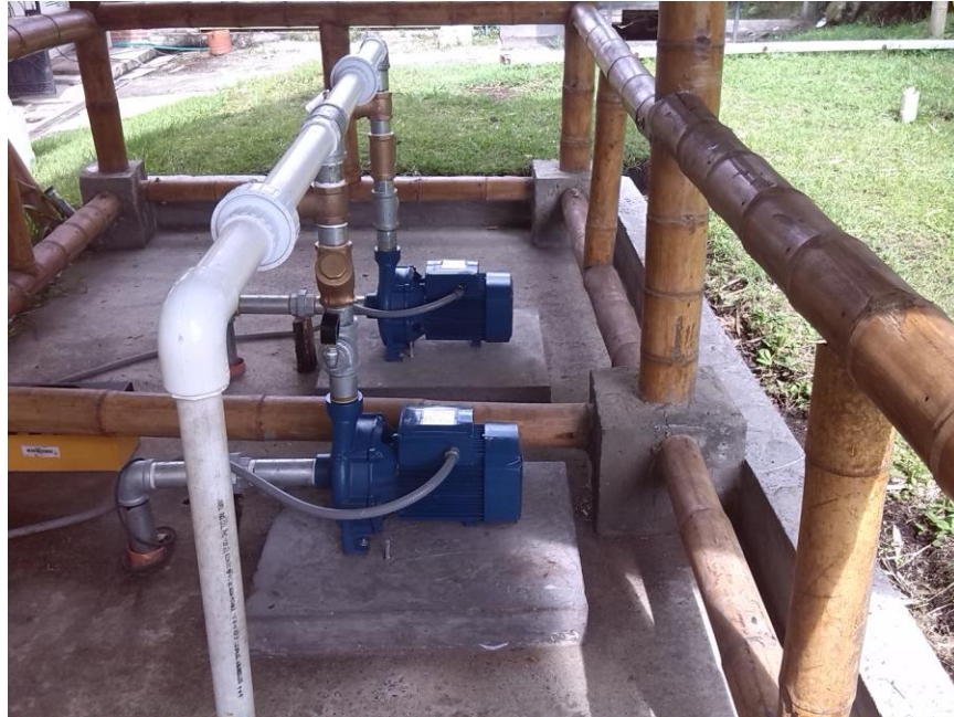
Figura 3.9 Conexión de bombas centrifugas en paralelo.
