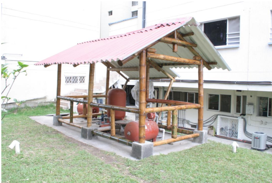
Figura 3.8 Caseta para cuarto de control terminada
